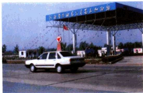
河南省石油总公司驻马店分公司 金山加油站
