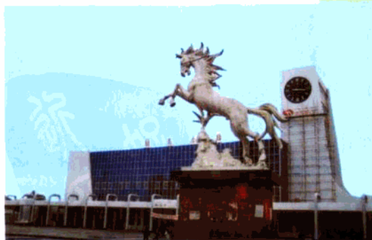
驻马店火车站——宏伟壮观， 充分展现驿城风貌的车站广 场外景
