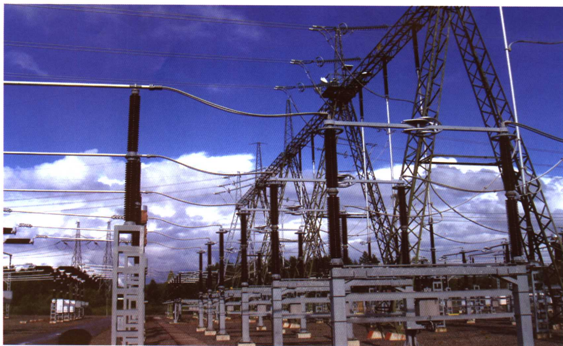
图7 格构式人字柱角钢塔架结构
