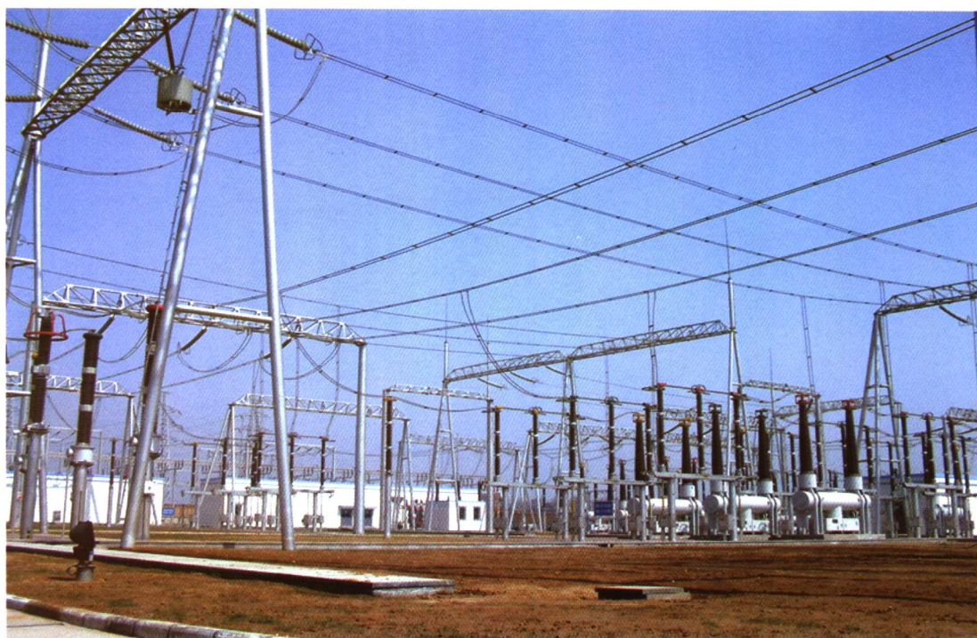
图14 焊接连接喷锌防腐构架
