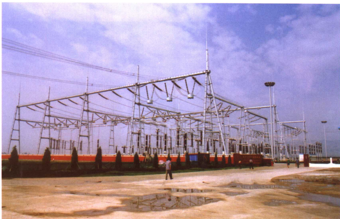
图8 高强度钢管梁柱结构
