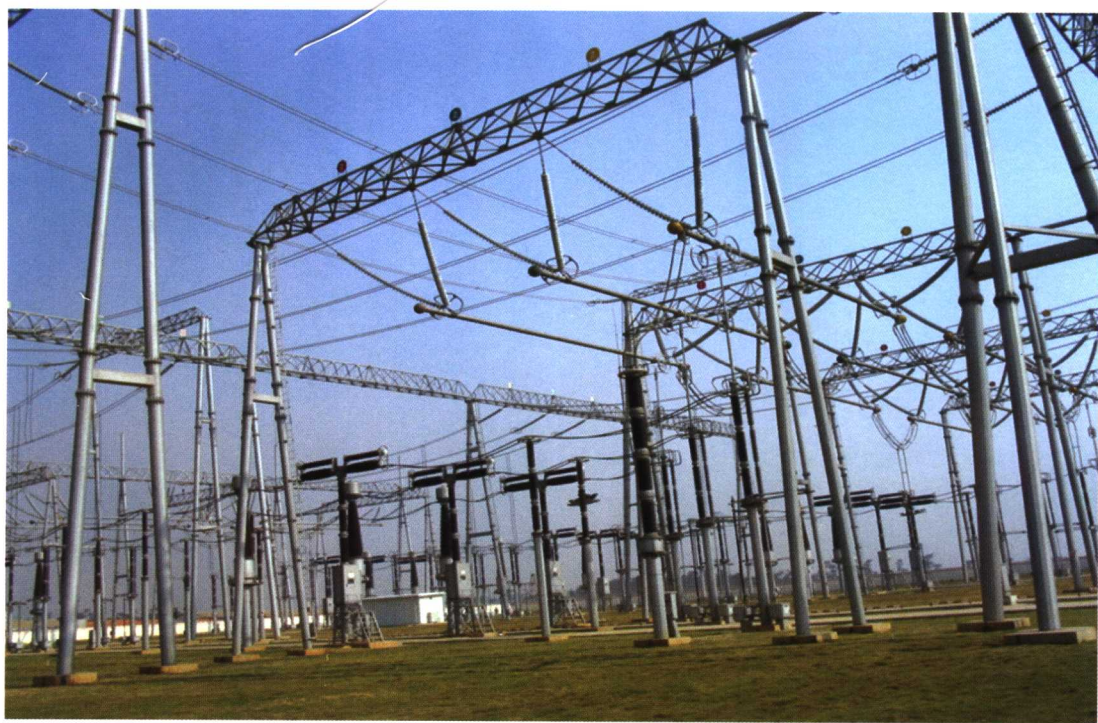
图4 焊接普通钢管结构
