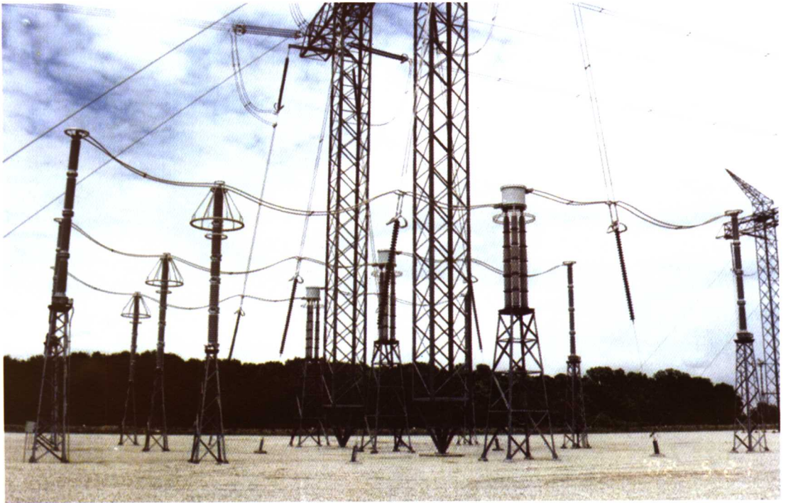
图12 打拉线结构(一)
