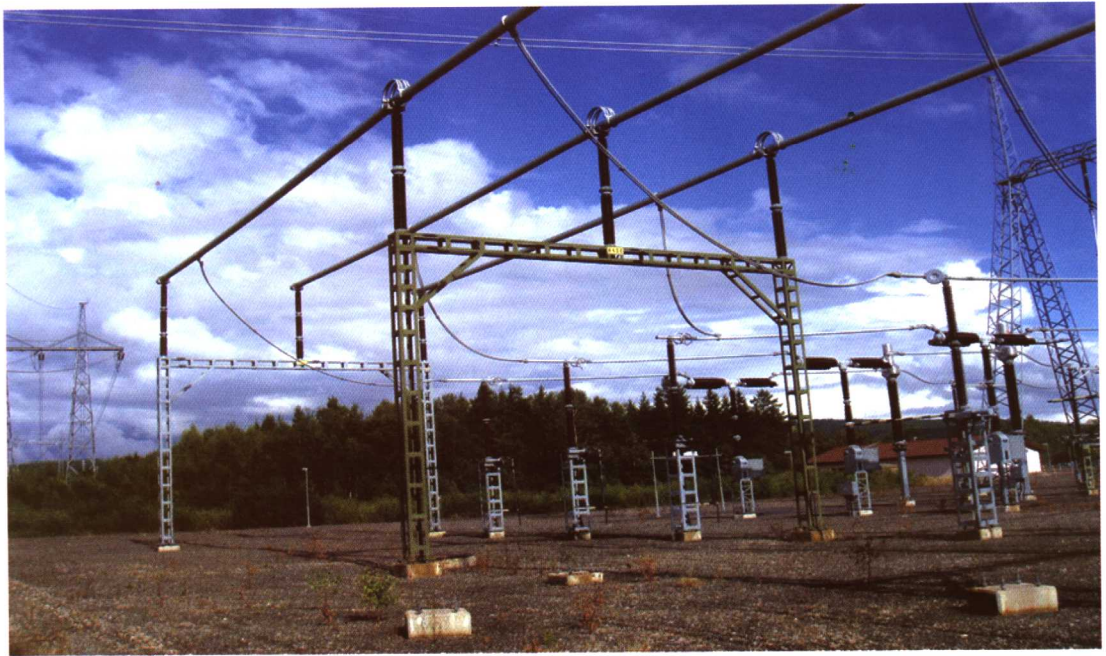
图15 防腐涂料防腐构架
