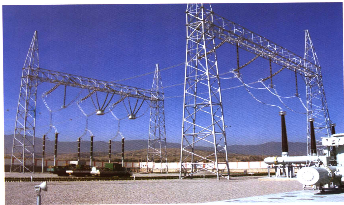
图6 格构式直立钢管塔架结构
