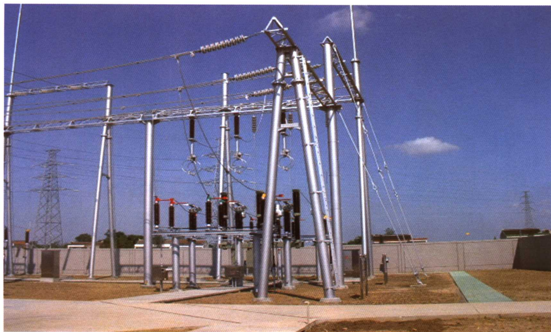
图13 打拉线结构(二)
