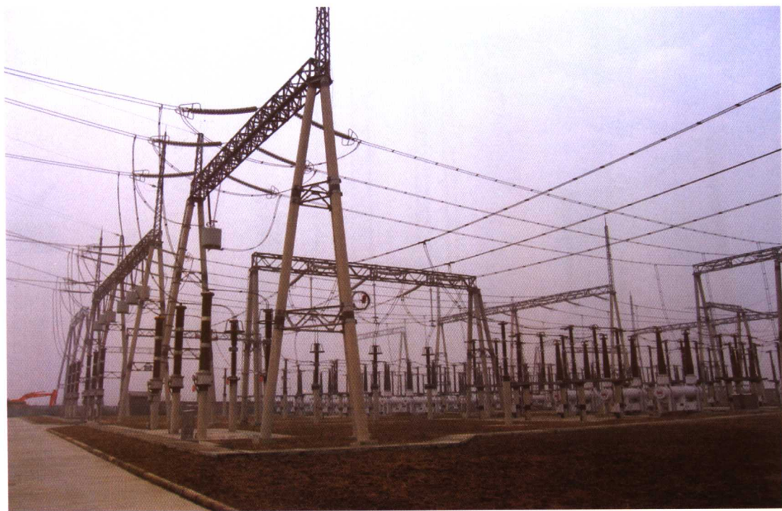
图10 环形截面钢盘混凝土柱结构
