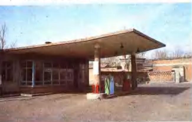
▼ 南关地道桥加油站
