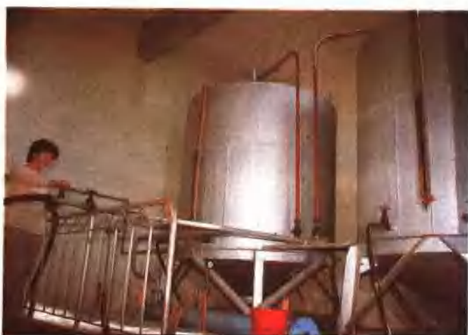
副食品厂酱油车间 ▶ 一角
