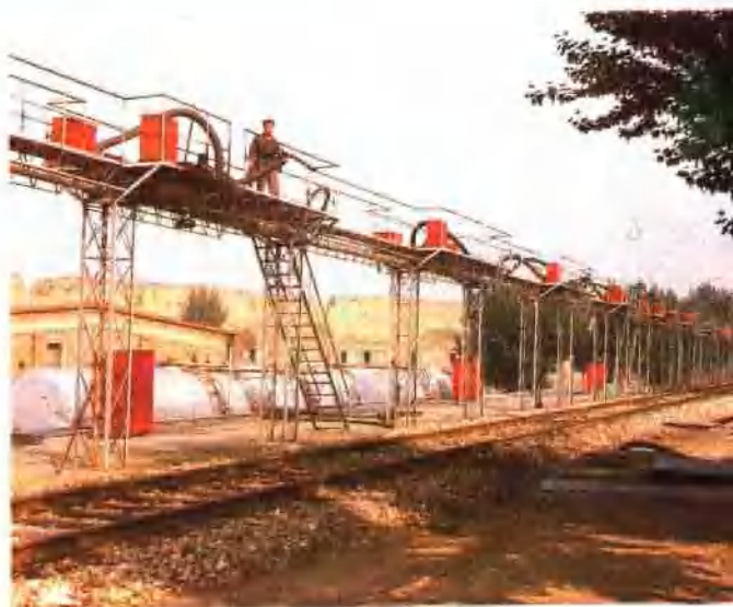
石油公司自动卸油线 ▶
