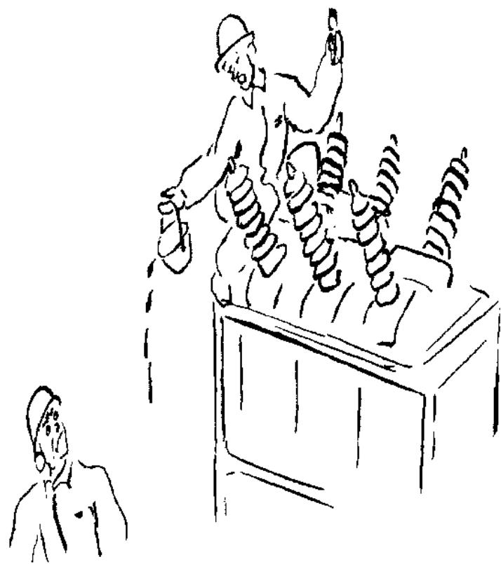
2 约 10 时 37 分、检修班工人赵××（男 29 岁）在 35kV 496（××线）断路器上清扫，刷完相序漆后，由于站立不稳失去重心，油漆垂直洒落在 496 断路器下部。
