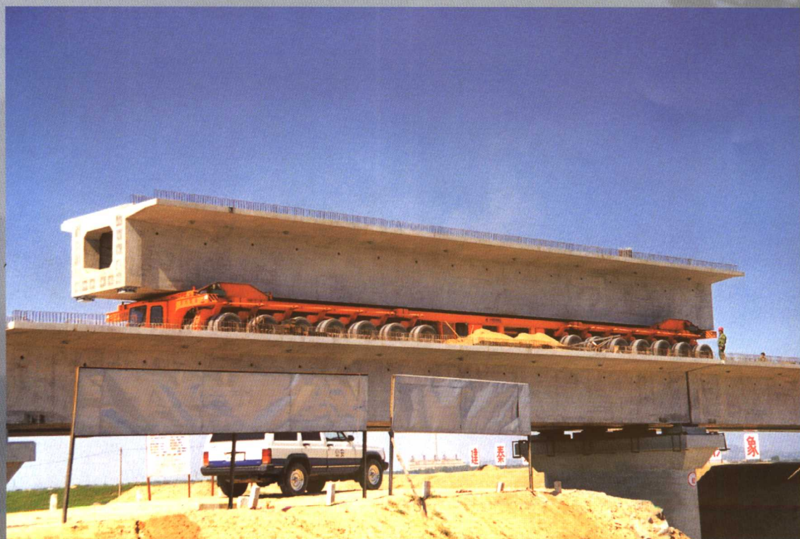
▲ DCY450 型运梁车在已架梁上运梁
