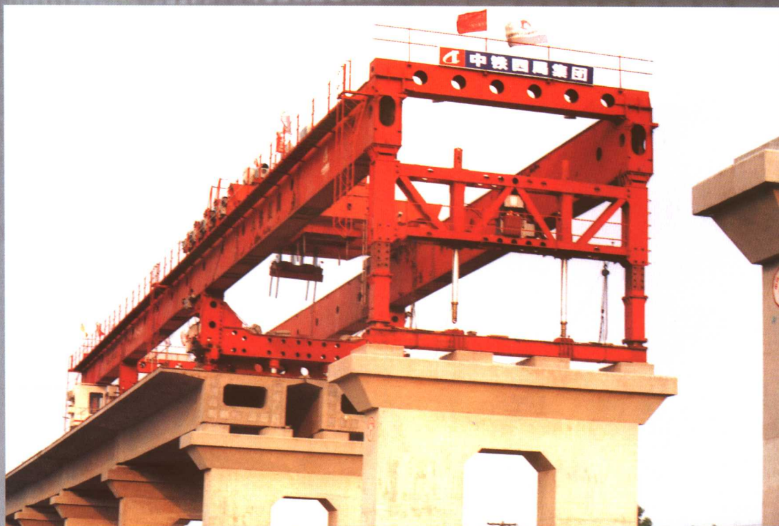
▲ DF450 型架桥机在待架孔上待梁
