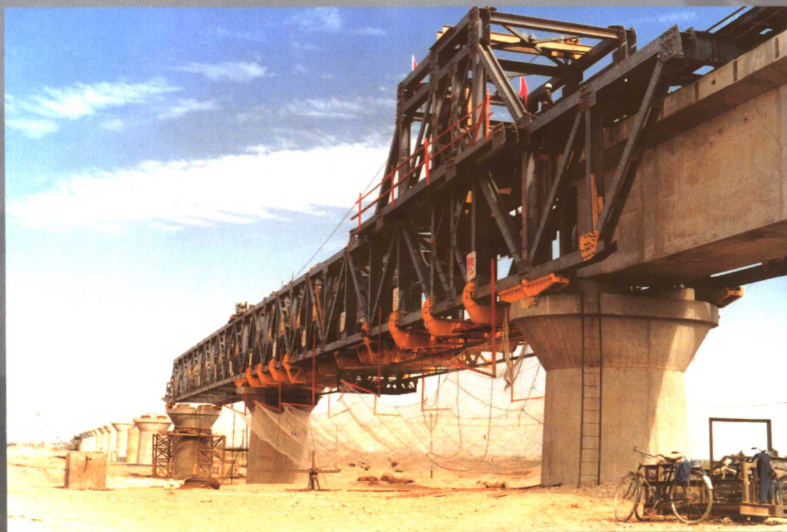
▲ ZQJ32/56 型移动支架在宁夏灵武黄河大桥施工图之二
