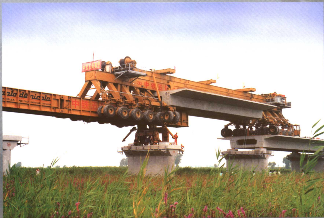
▲ 550t吊运架一体机导梁前移即将完成，准备落梁就位
