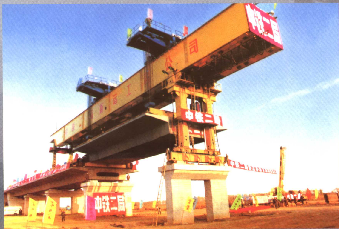
▲ JQ600 型架桥机架设24 m箱梁
