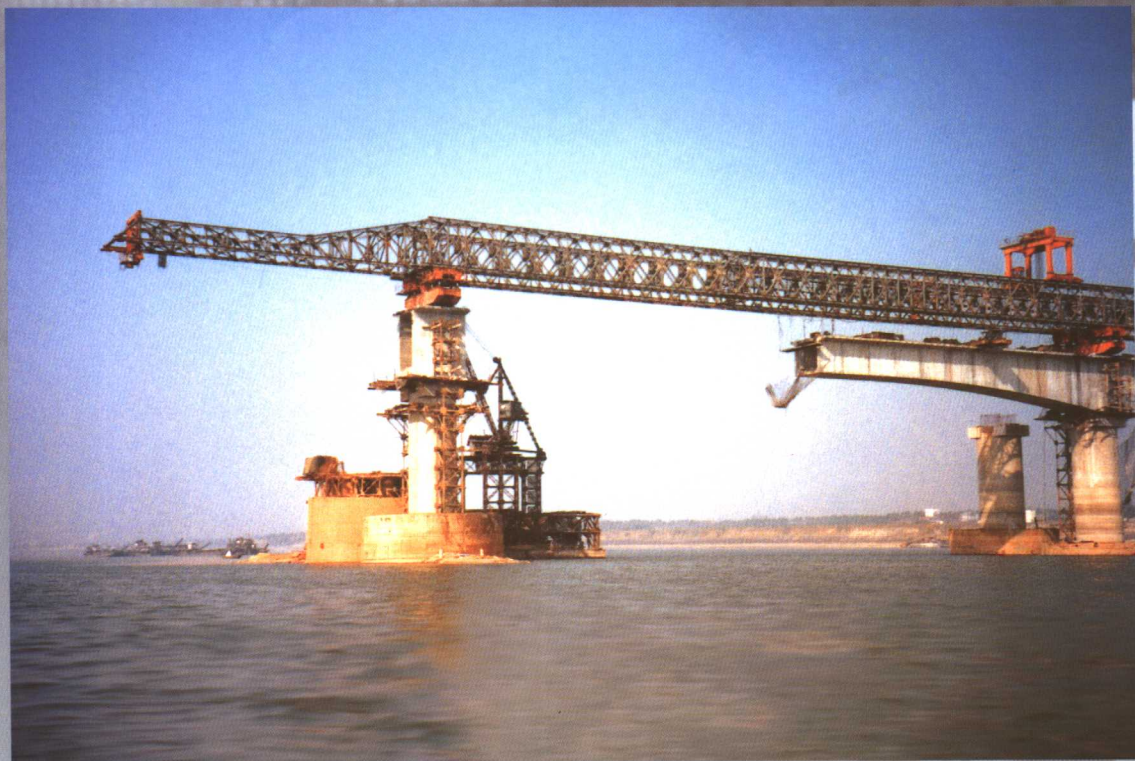
▲ 中铁大桥局 96 m 移动支架在石长线湘江大桥上施工
