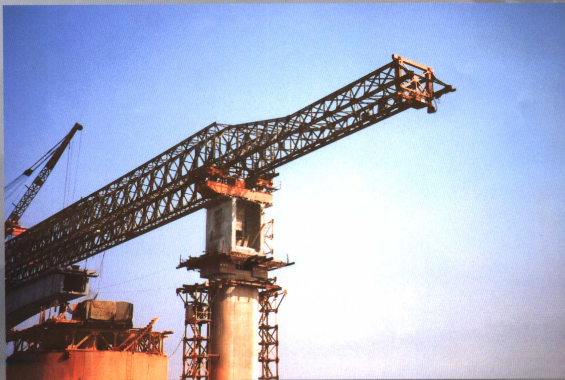
▲ 中铁大桥局 96 m 移动支架正准备平衡悬架混凝土箱梁节段
