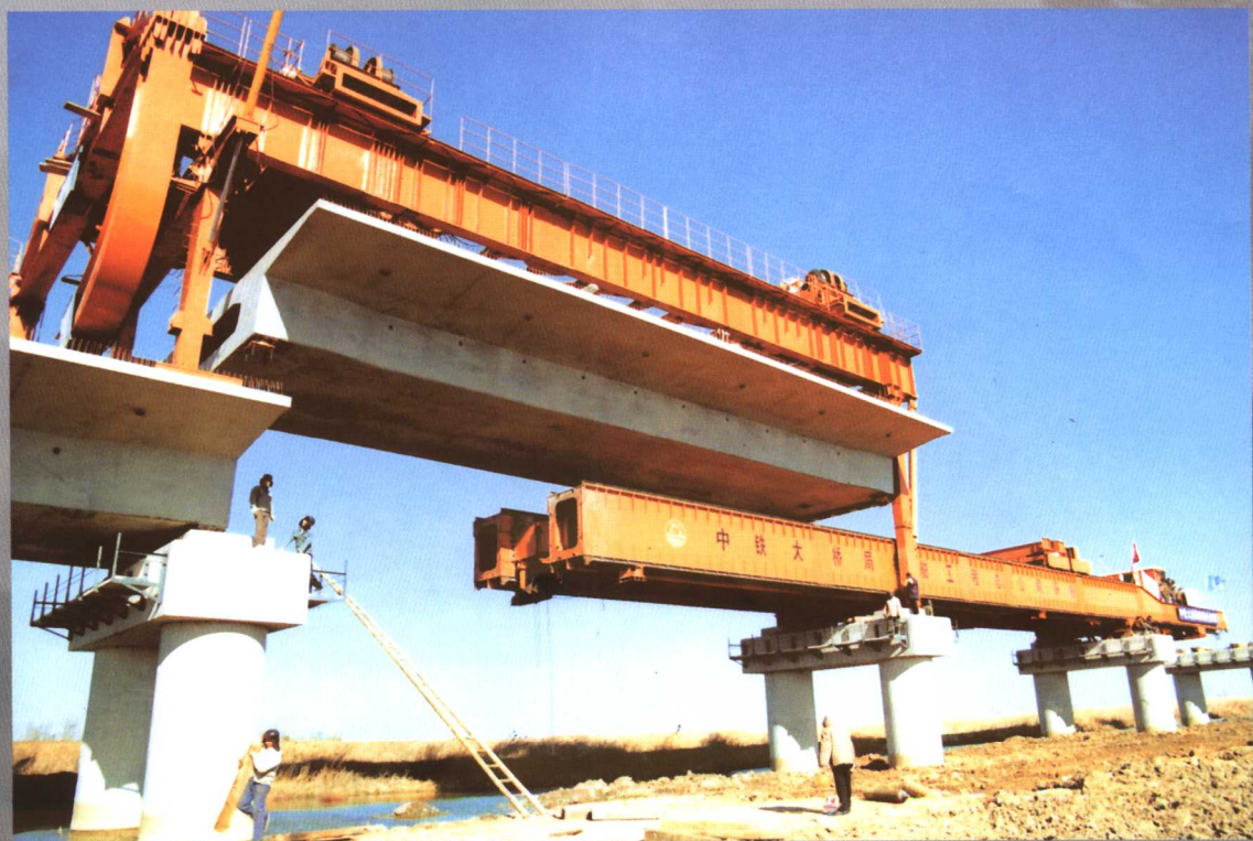
▲ JQ600 型架桥机导梁前移，空出桥位
