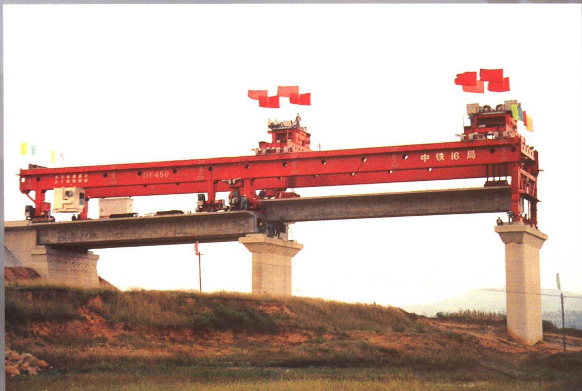
▲ DF450 型架桥机正在桥位上落梁
