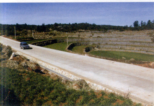
弥勒西部连乡公路，在西一镇穿梭 30 公里，经过 8 个自然村，被誉为弥勒县民族文化旅游走廊。
