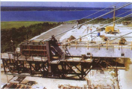
前支点吊索挂篮
