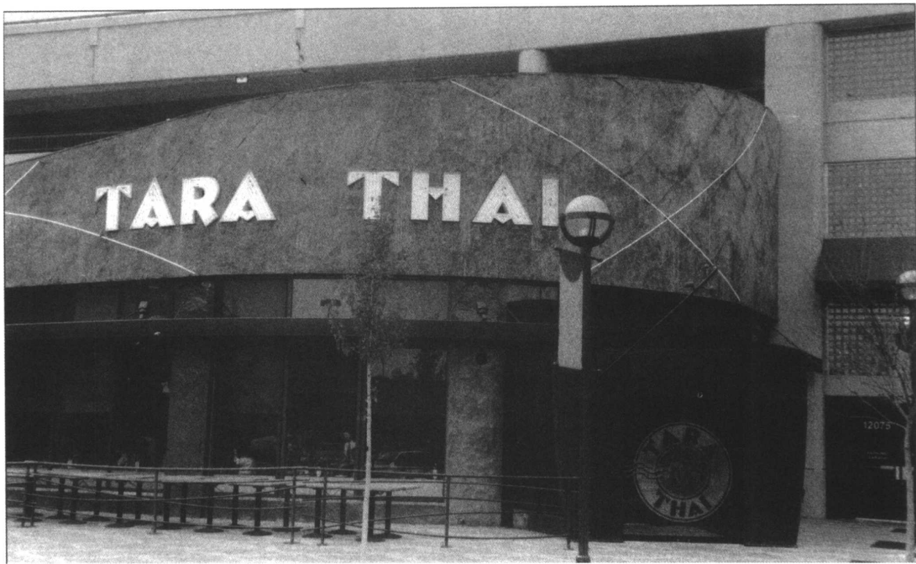
图 1.5 位于 MD Rockville 的 Tara Thai 餐馆的设计主题是通过建筑、室内装饰和灯光来表现的，而非亚洲式餐馆陈腐的设计主题
