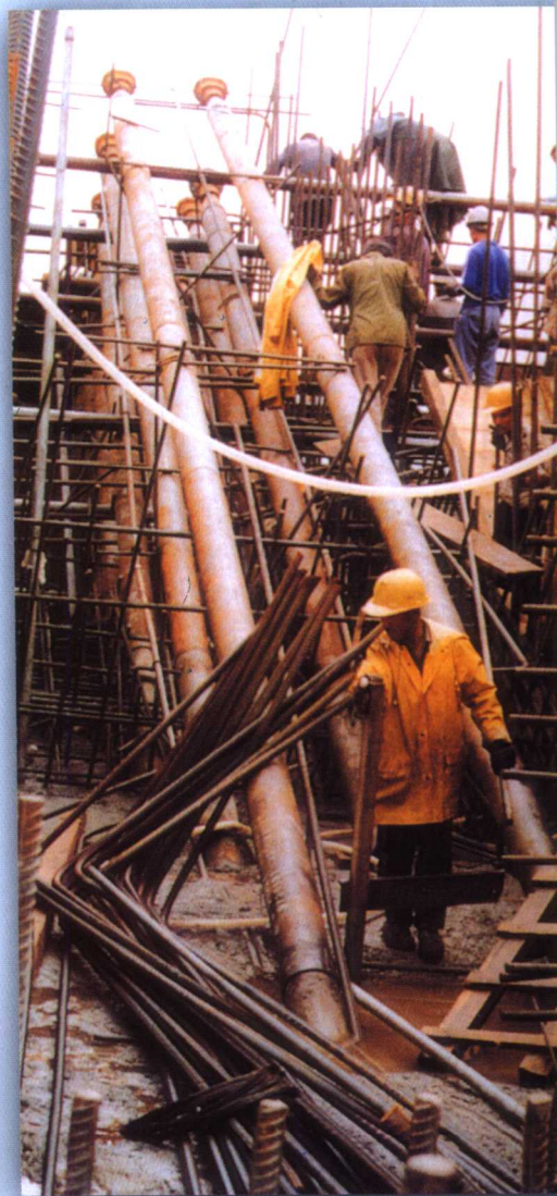
中孔悬臂预应力锚索护管 上部直线段埋设安装
