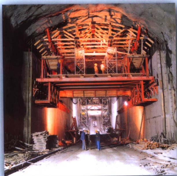
泄洪洞奥奇段顶拱混凝土施工
