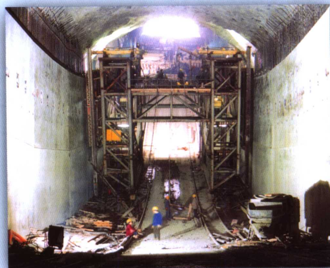
泄洪洞边墙混凝土浇筑
