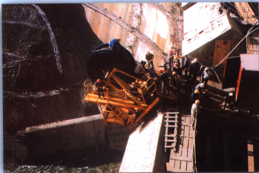
中孔悬臂预应力锚索施工（装索）
