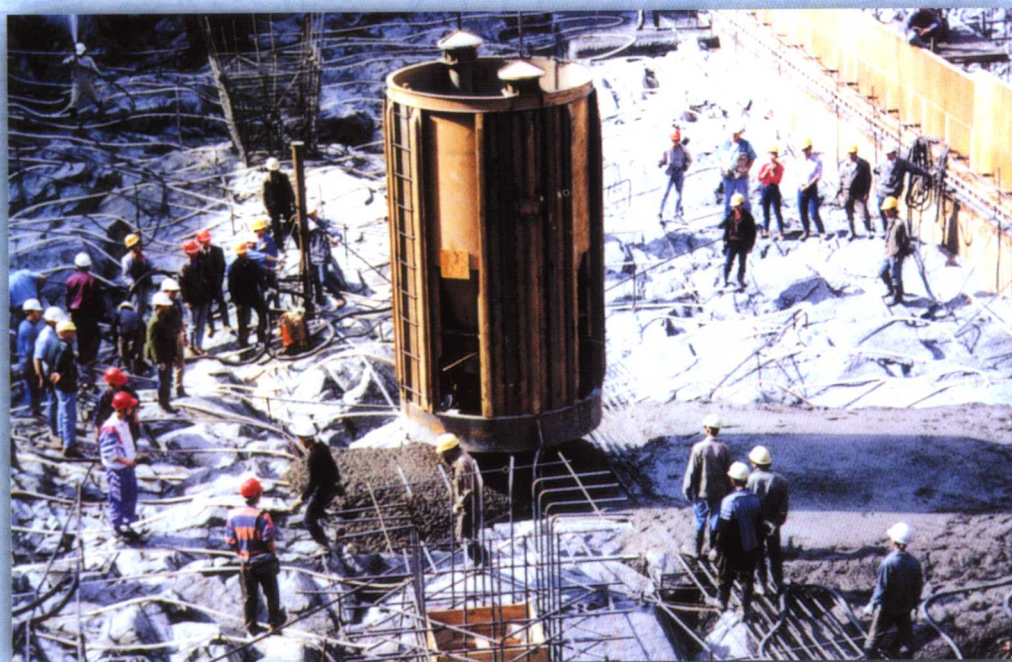
1995年2月23日第一罐混凝土流入坝基
