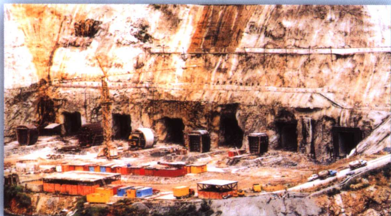
完成开挖后的电站进水口
