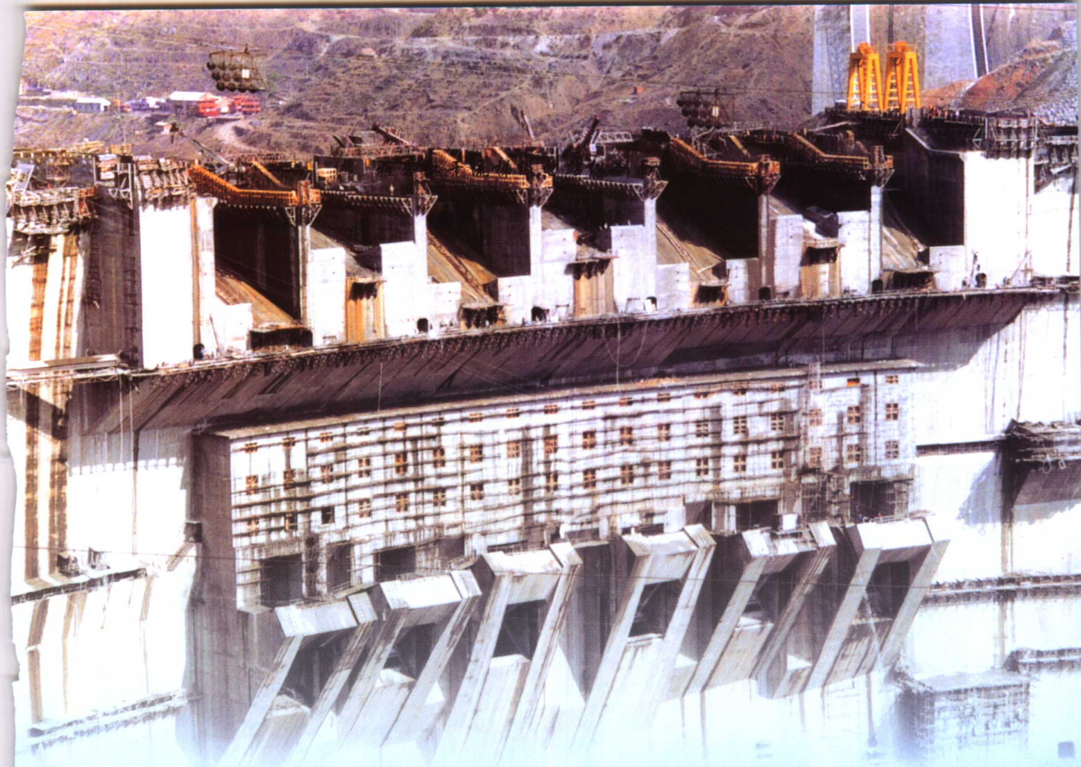
施工中的表孔和中孔
