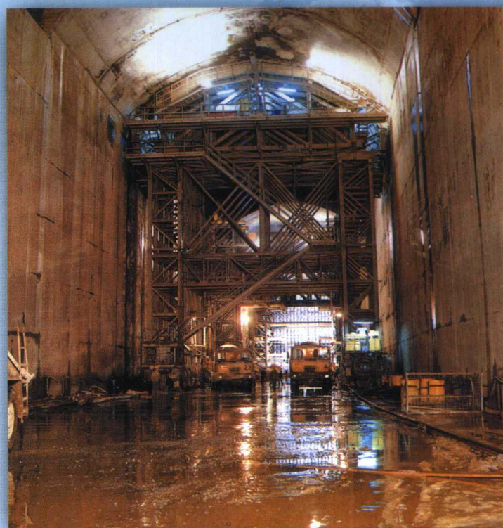
导流洞混凝土衬砌施工的钢筋台车
