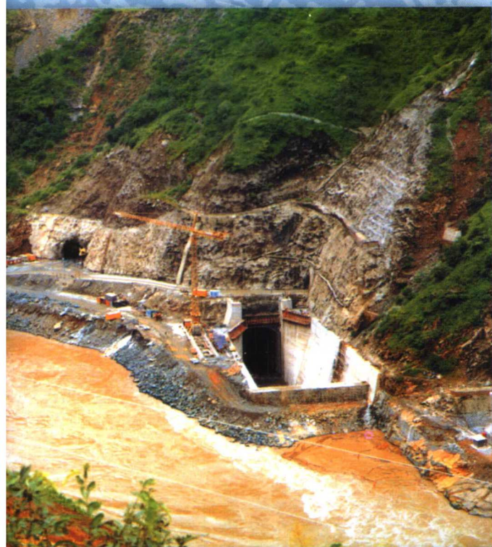
左岸导流洞出口围堰
