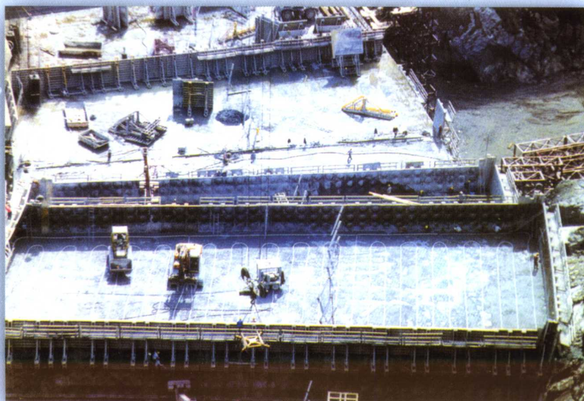
仓面铺设的高强聚乙烯 (HDPE) 冷却水管远景
