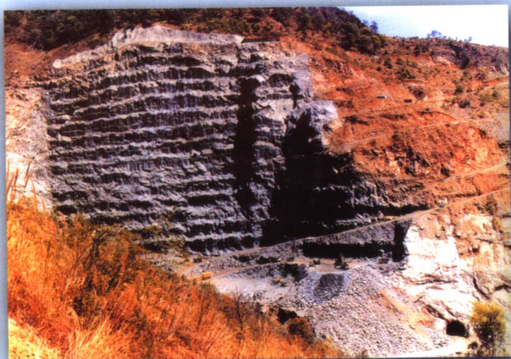
大坝混凝土骨料采石场全貌
