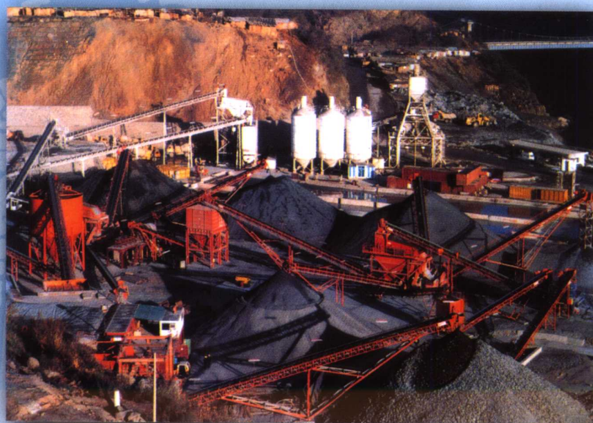
地下工程砂石骨料加工场 及混凝土拌和系统近景
