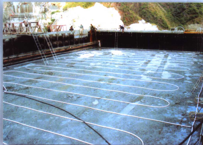
仓面铺设的高强聚乙烯 (HDPE) 冷却水管近景
