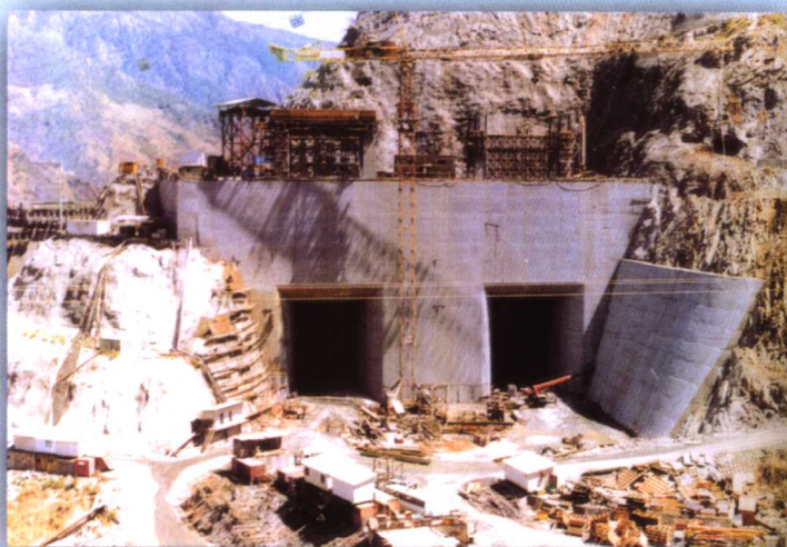
泄洪洞进口混凝土施工
