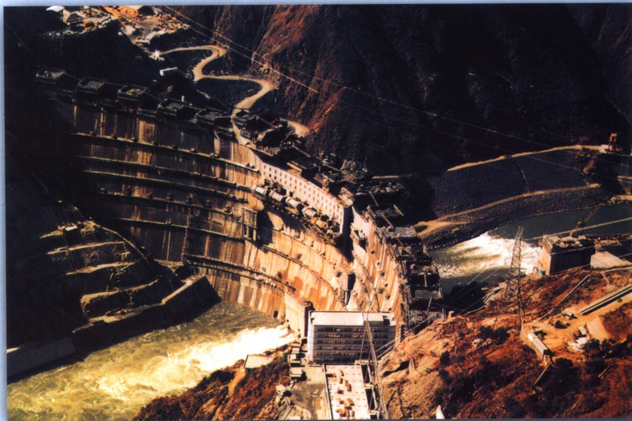
大坝临时导流底孔过水实现二期导流
