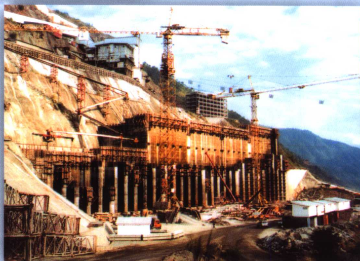
电站进水塔混凝土施工
