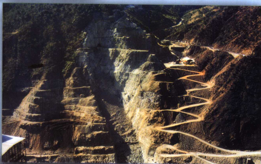
右岸坝肩开挖
