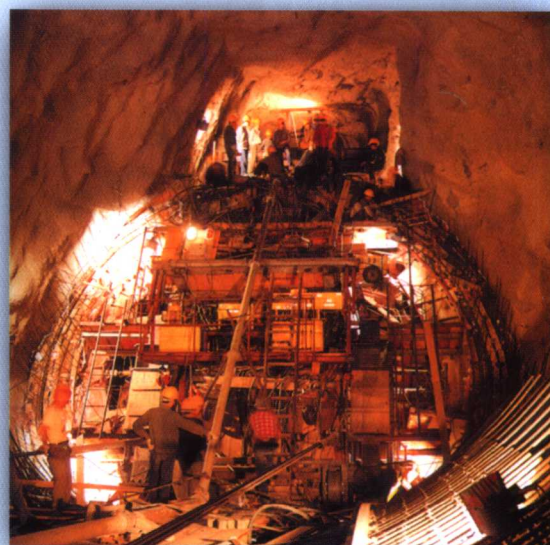
引水管道上弯段混凝土衬砌用钢模台车全断面浇筑
