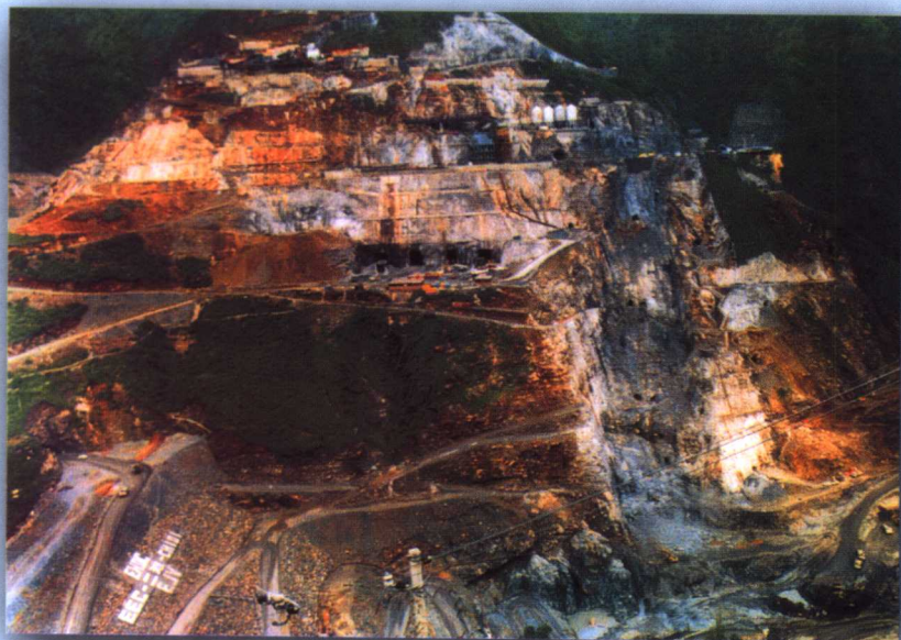
左岸坝肩开挖
