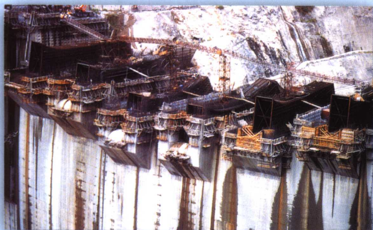
中孔钢衬施工
