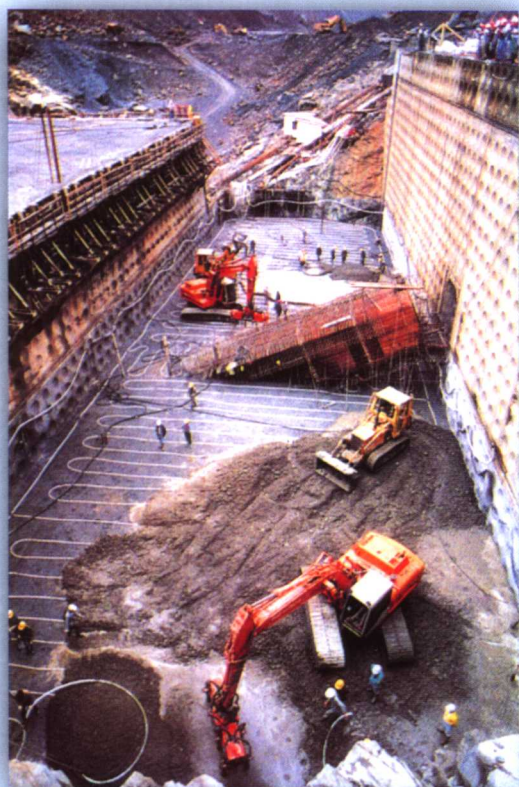
混凝土平仓和振捣（仓面两侧可见横缝球面键槽）
