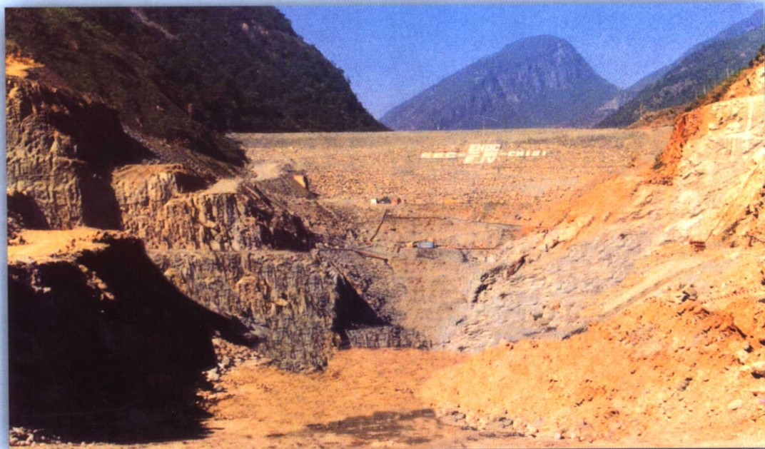
上游围堰与基坑全貌
