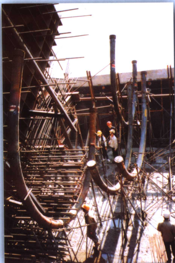
中孔悬臂预应力锚索护管下部U形段埋设安装
