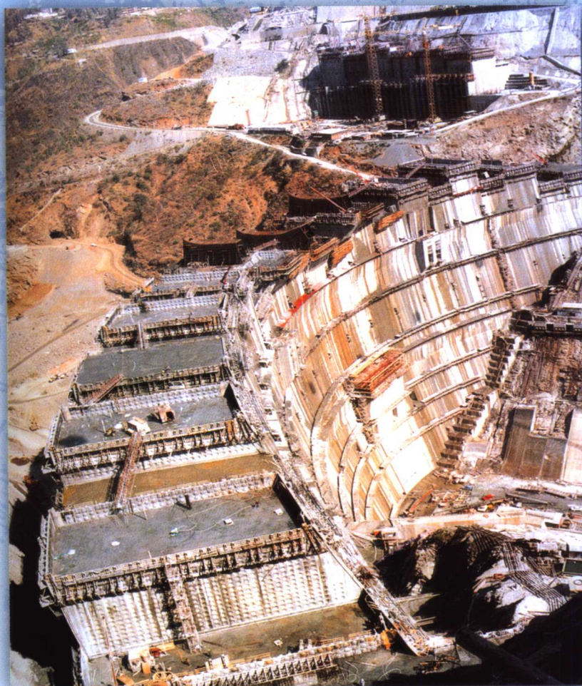
浇筑中的大坝全景
