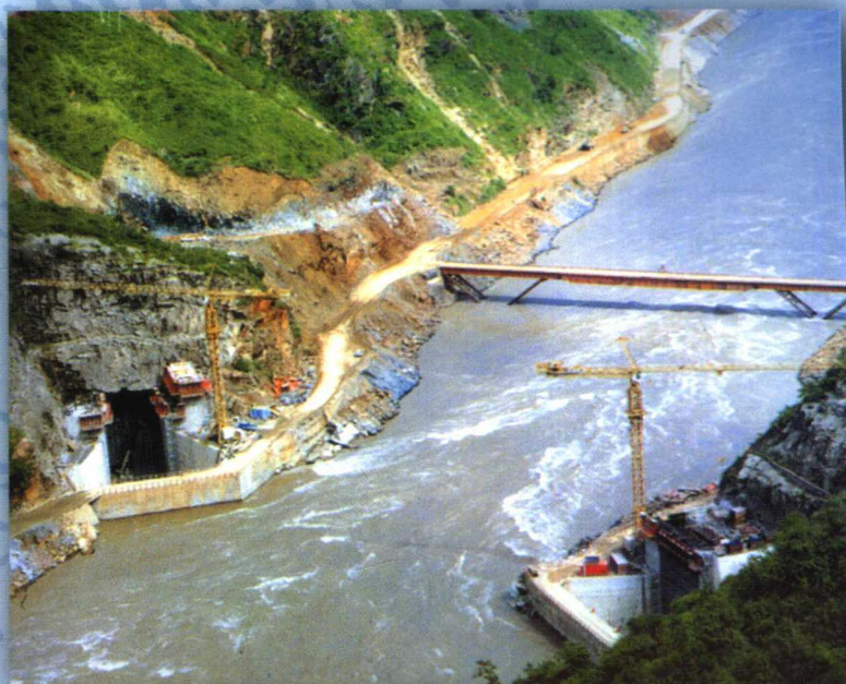
导流洞进口围堰及平堵抛投钢栈桥
