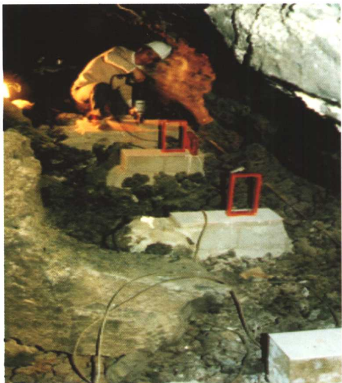
在隧道中的Cueva站里为装校CE-92潮汐变形观测仪器做基础工作
