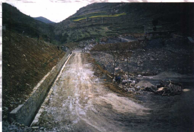
建设中的工业大道
