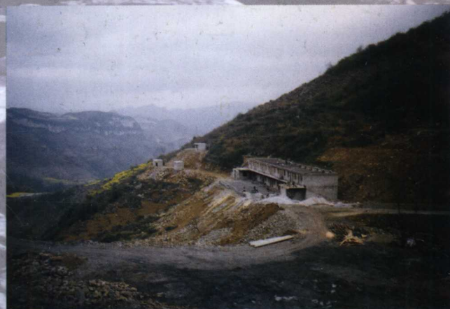
建设中的新井综合楼
