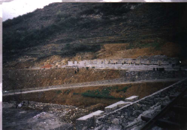
建设中的矿工宿舍楼
