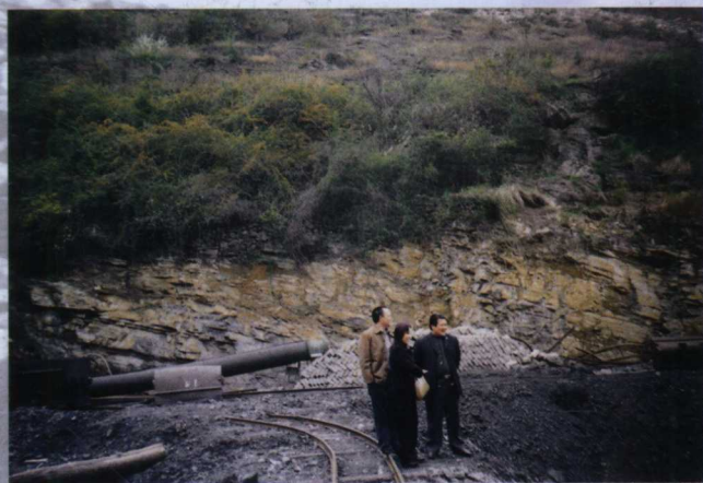
矿长王传信（右）在新井建设现场
