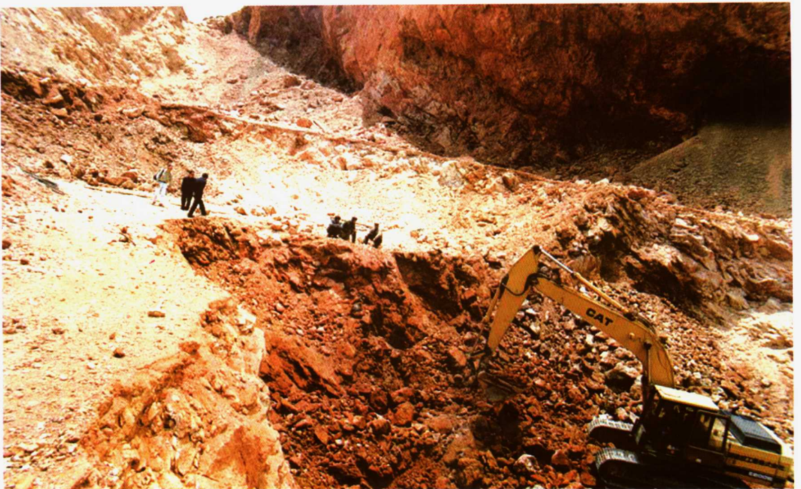
玛曲大水金矿 20 号主矿体采矿掌子面
