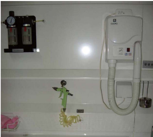
干燥台（压力气枪、干燥器）
