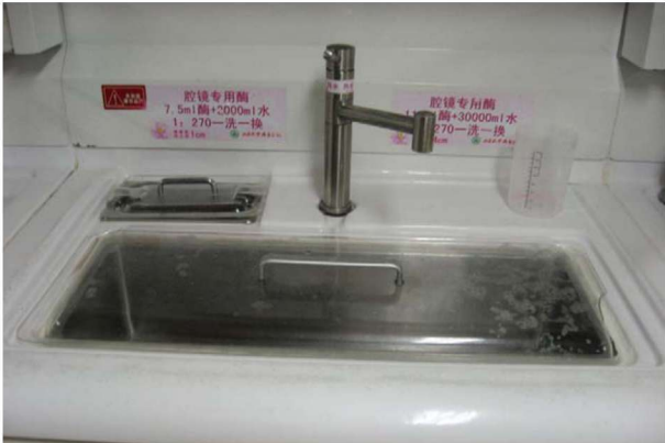
洗涤槽（常水、热水或镶嵌超声波清洗机）
