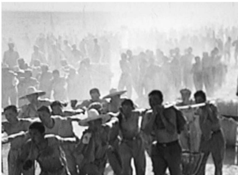
工程兵修建通往试验场区的公路
