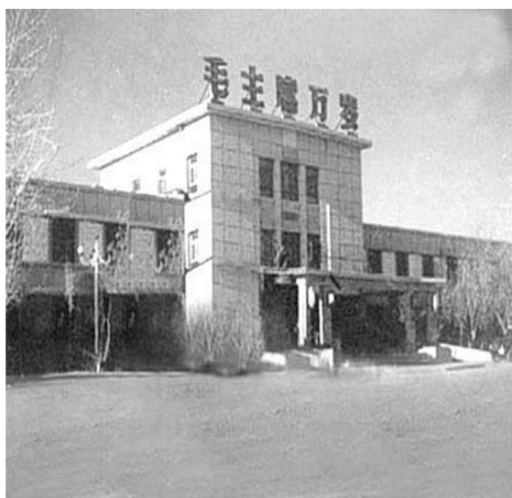
546医院住院大楼
