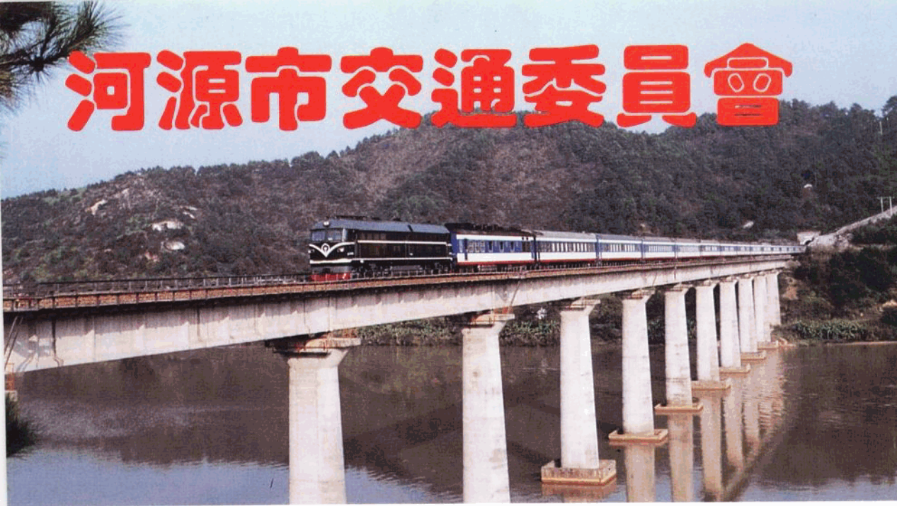
旅客列车通车龙川东江铁路大桥雄姿
