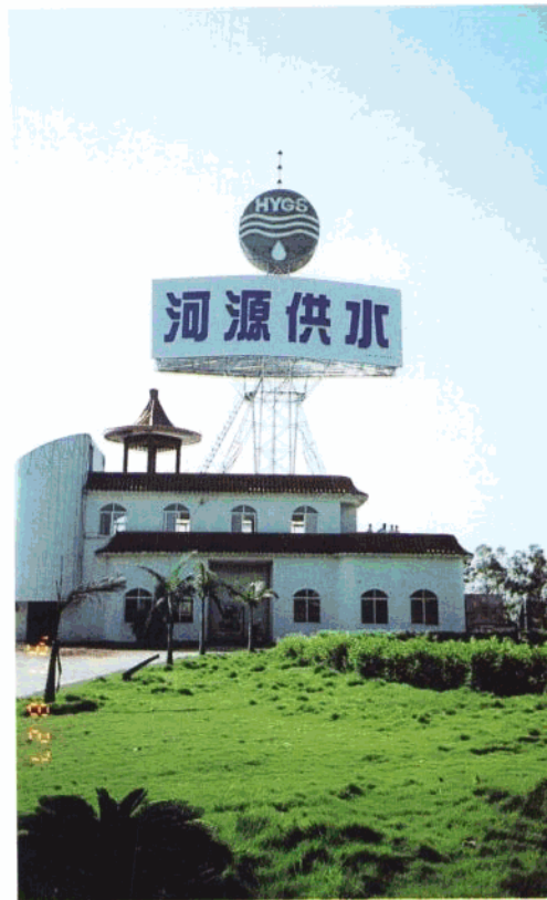
河源市新区供水工程，是市水利局，建设管一体化的全民企业。日供水能力5.3万吨。保证了新区生产生活用水。
