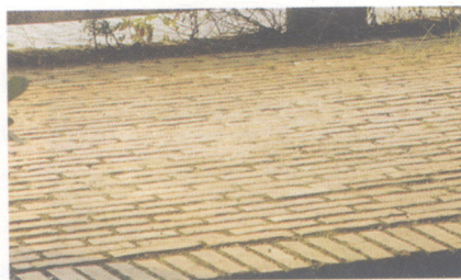
非粘土烧结砖铺地(见 \frac{5}{28} )
