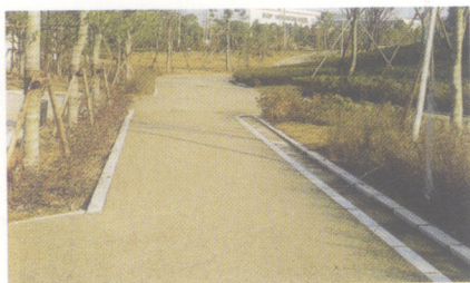
脱色沥青混合料铺地
