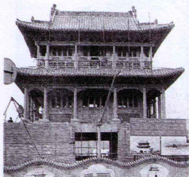
重建中的北门城楼
