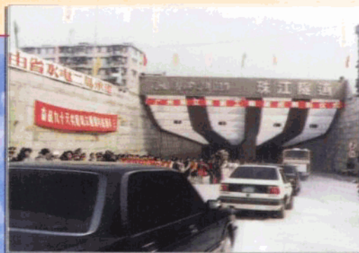
该局承建的广州珠江过江隧道工程，工程获国家科学技术进步“二等奖”
