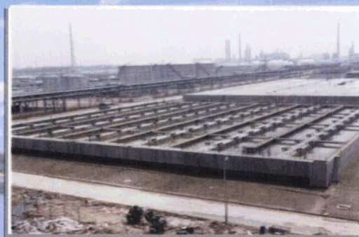
该局承建的广东茂名三十万吨乙二醇污水处理厂工程。
