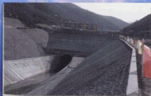
该局承建的东江—深圳供水三期扩建工程6.4公里的雁田隧洞，工程获省科学技术进步一等奖
