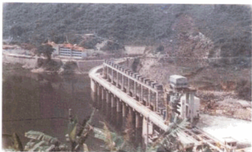
天生桥二级水电站首部枢纽
