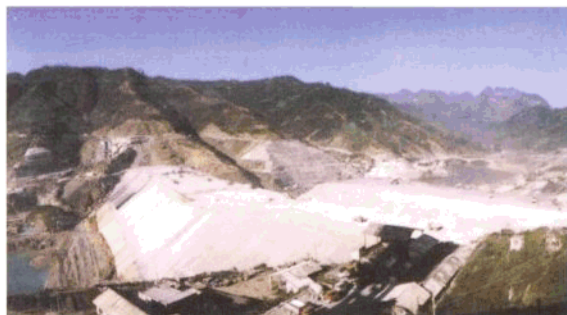
正在建设中的天生桥一级水电站(4 × 300MW)
