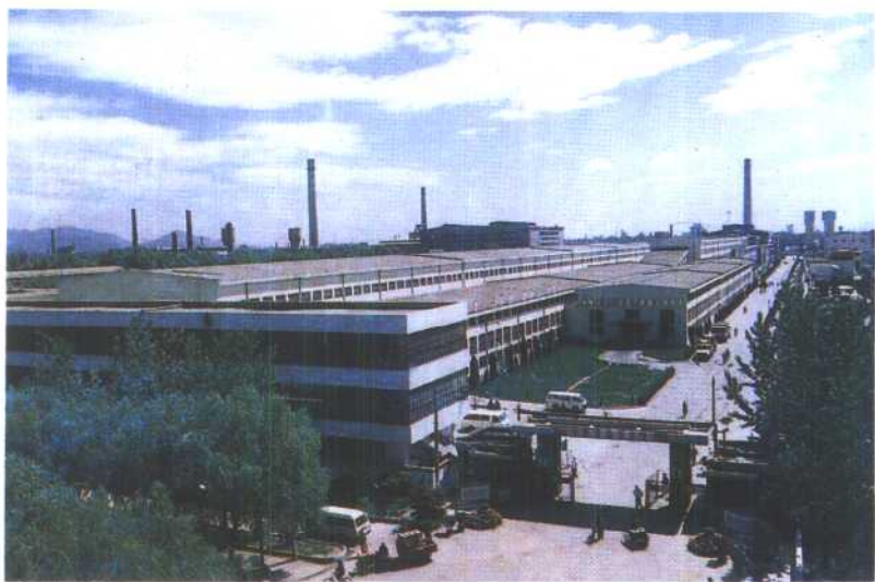
耀华玻璃厂于80年代新扩建的浮法玻璃生产厂区及多层中空玻璃生产线。
