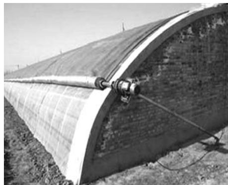
图 1-6 钢筋砖混保温被覆盖日光温室
