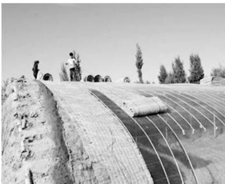
图 1-5 钢筋土墙结构草帘覆盖日光温室
