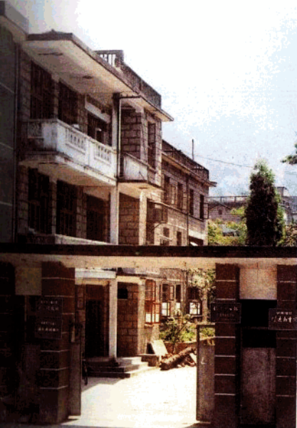
宁德地区卫生防疫站实验楼建于1973年，建筑面积1728m 2 。
