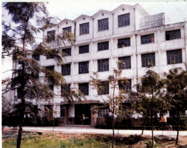
福州市郊区卫生防疫站实验楼建于1984年， 建筑面积1824m 2 。
