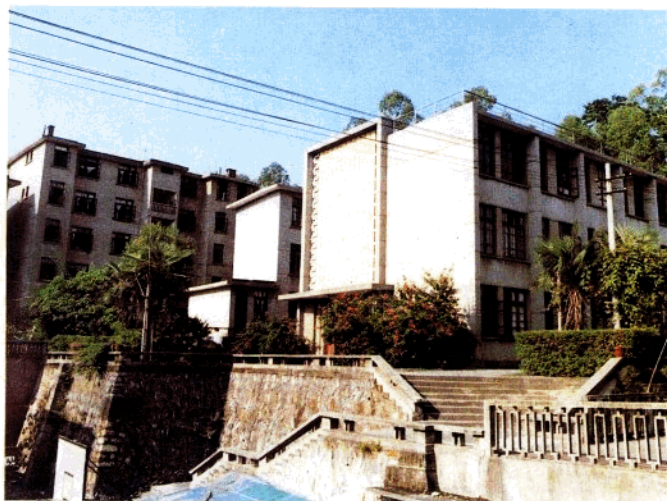
龙岩地区卫生防疫站实验楼建于1979年，建筑面积1234m 2 。
