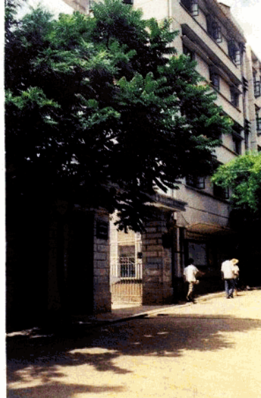
莆田县卫生防疫站建于 1982年，总建筑面积3552m 2 。
