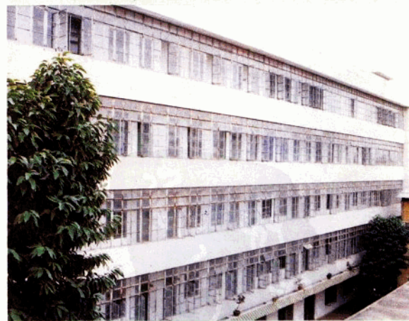
漳州市卫生防疫站实验楼建于1986年，建筑 面积1988m 2 。
