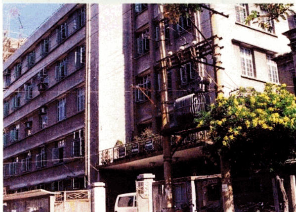
厦门市卫生防疫站实验综合楼建于1976年， 建筑面积2400m 2 。
