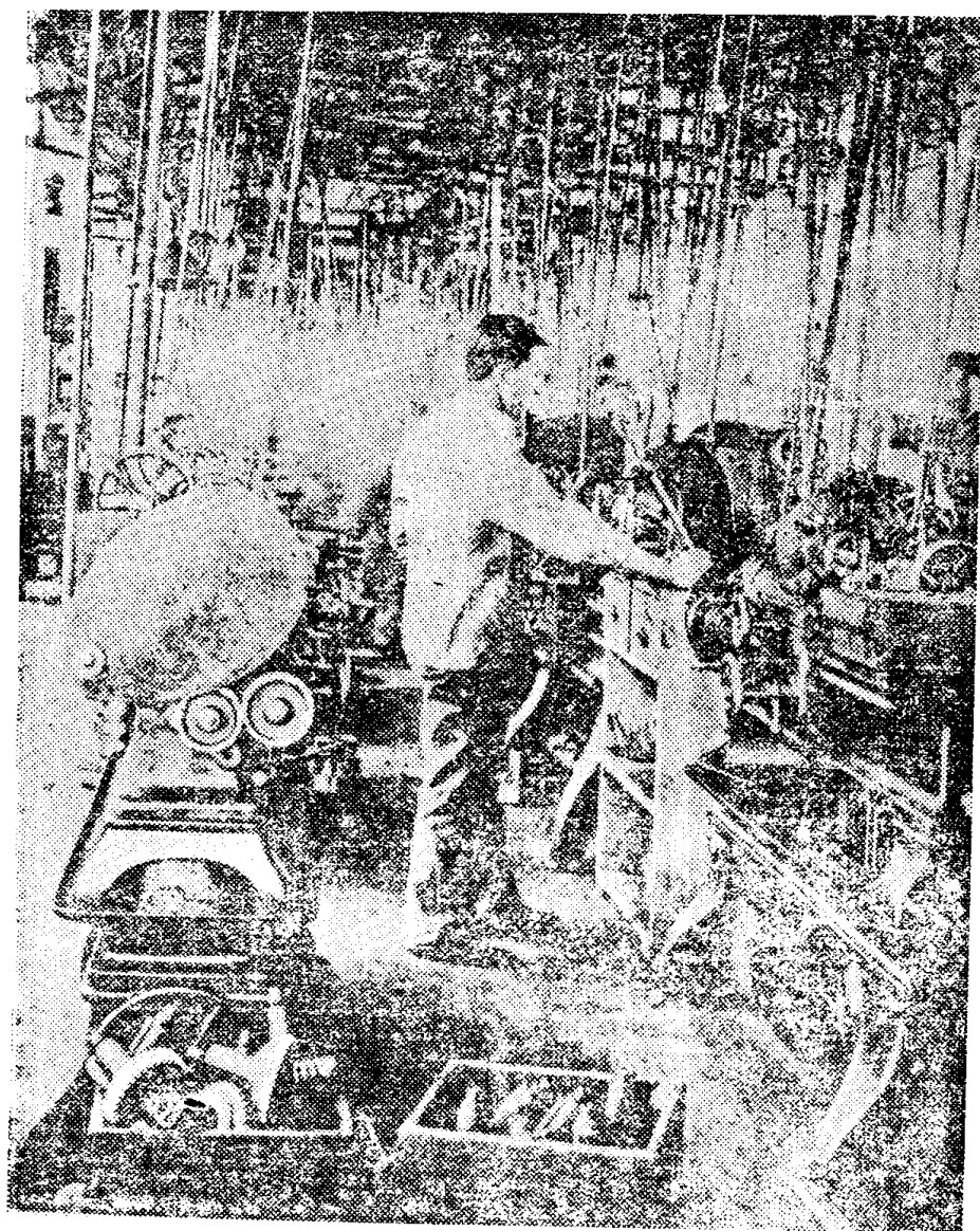
图1—2 这张旧照片表明：防护了手扳压床齿轮，但连接天轴的传动皮带却未加防护。1877年，美国第一个强制防护危险机器的法律在马萨诸塞州通过。受官方支持的检查队伍也建立起来了。
