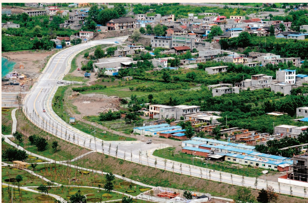
新建的茂县汾岷市政道路
