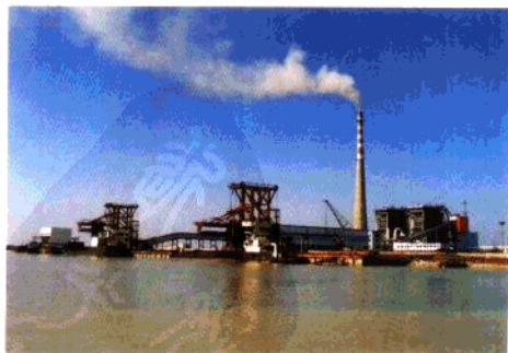
射阳港发电厂
