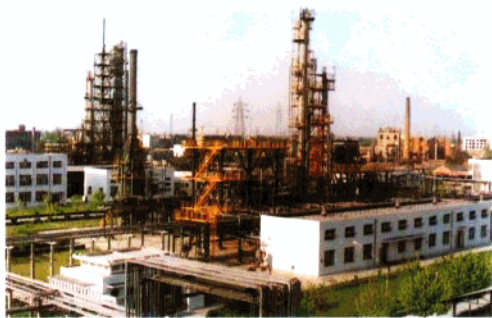
盐城市石油液化气厂
