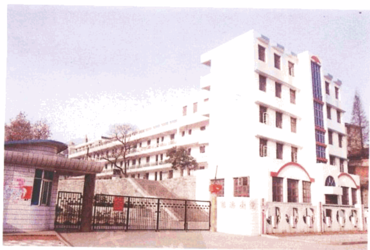
湖滨小学主体教学楼全景
