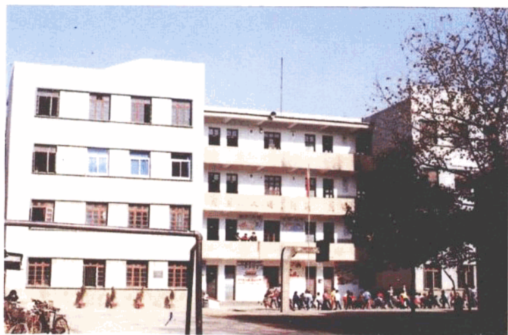
滨兴小学教学楼全貌
