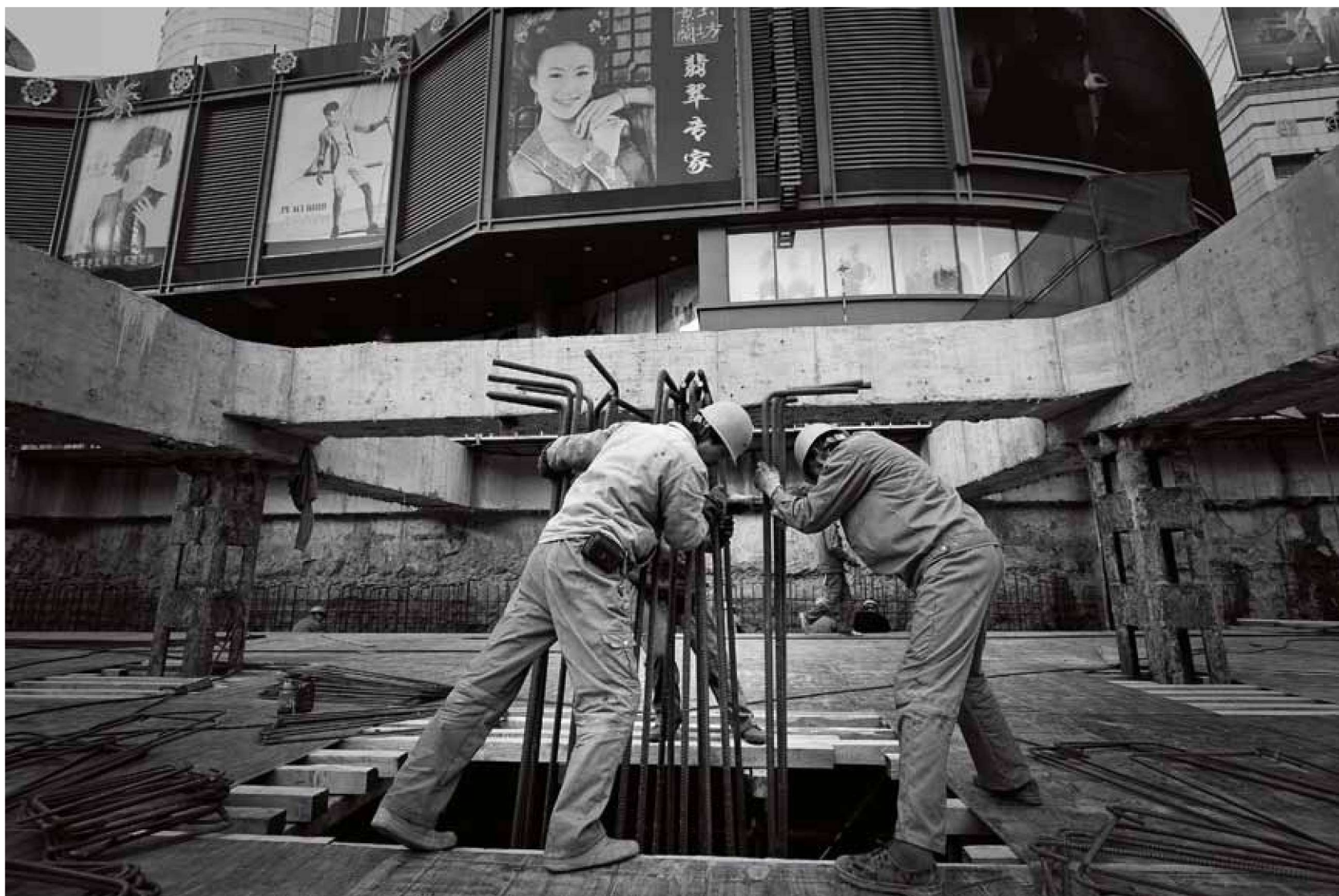
东门口站工地，工人们正在基坑里绑扎钢筋。（摄于2011年3月8日）
