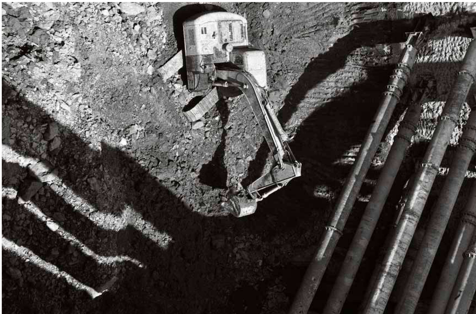
宁波火车站工地，挖土机在基坑里作业。（摄于2012年6月7日）
