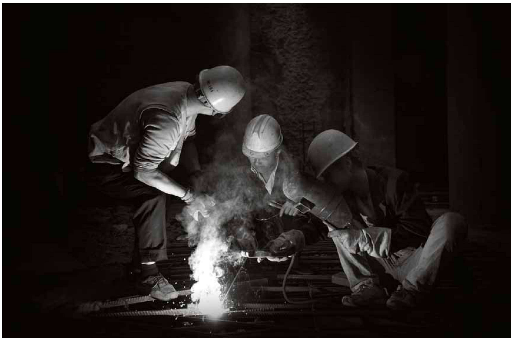
樱花公园站出入口，工人们正在焊接钢筋。（摄于2015年4月15日）
