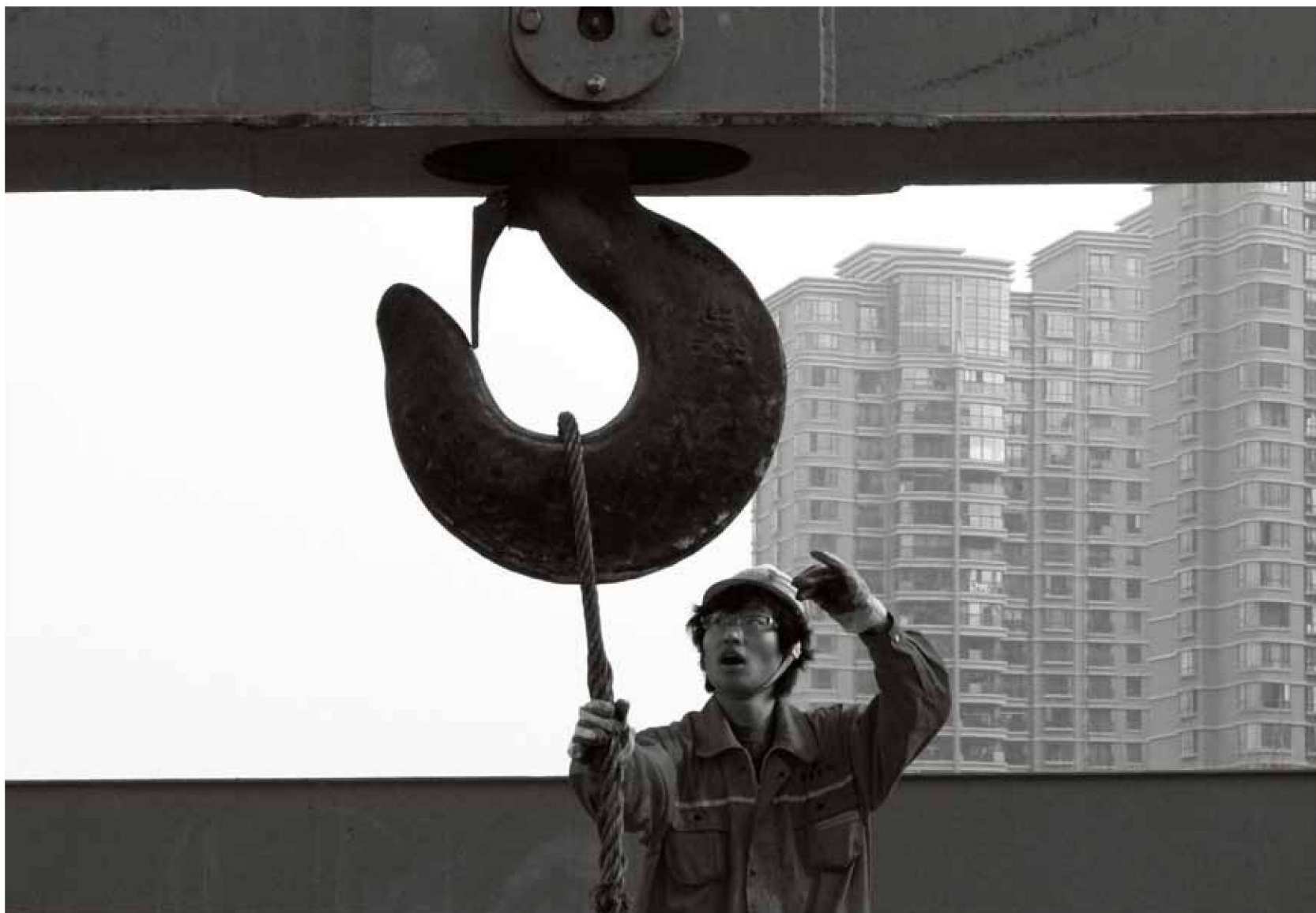
樱花公园站工地，一名青年工人正在起吊施工材料。（摄于2011年2月25日）
