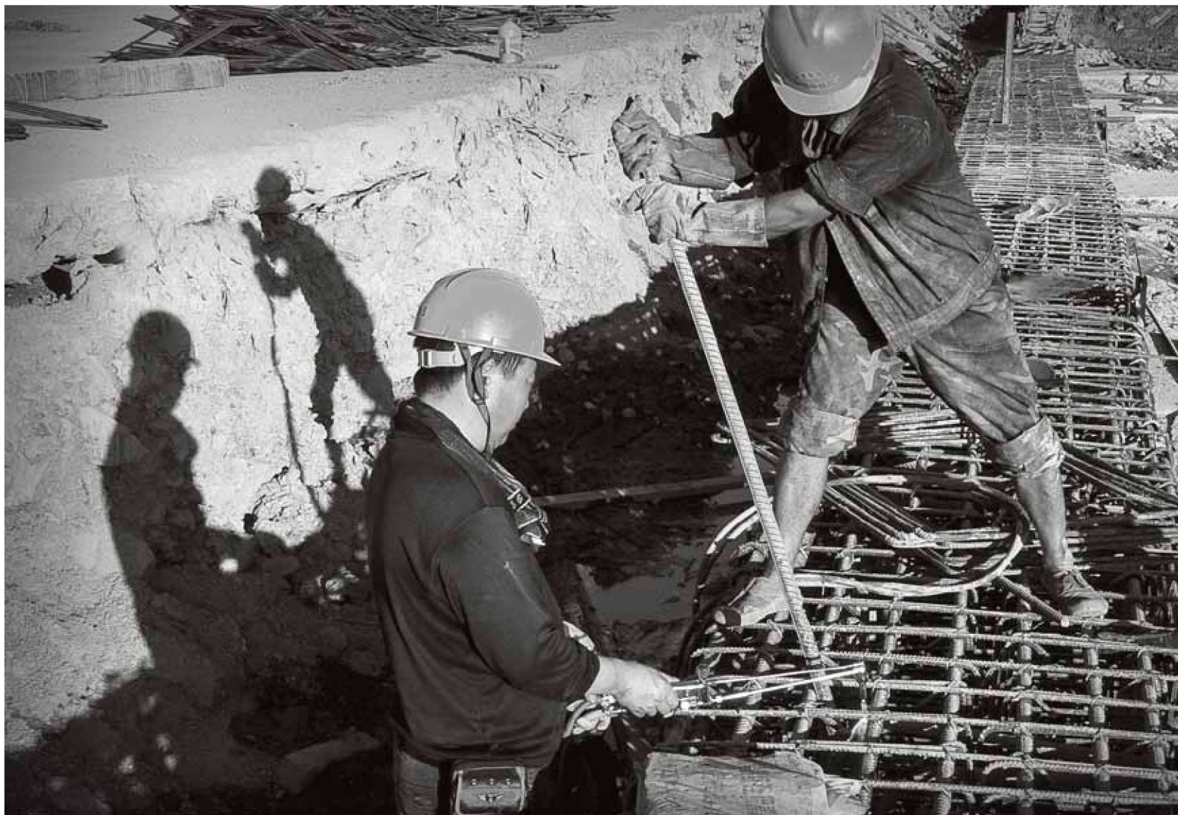
邱隘站，工人冒着酷暑焊接钢筋。（摄于2012年7月26日）
