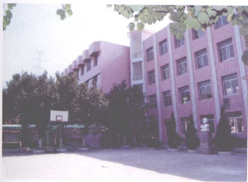
东渡小学教学综合楼
