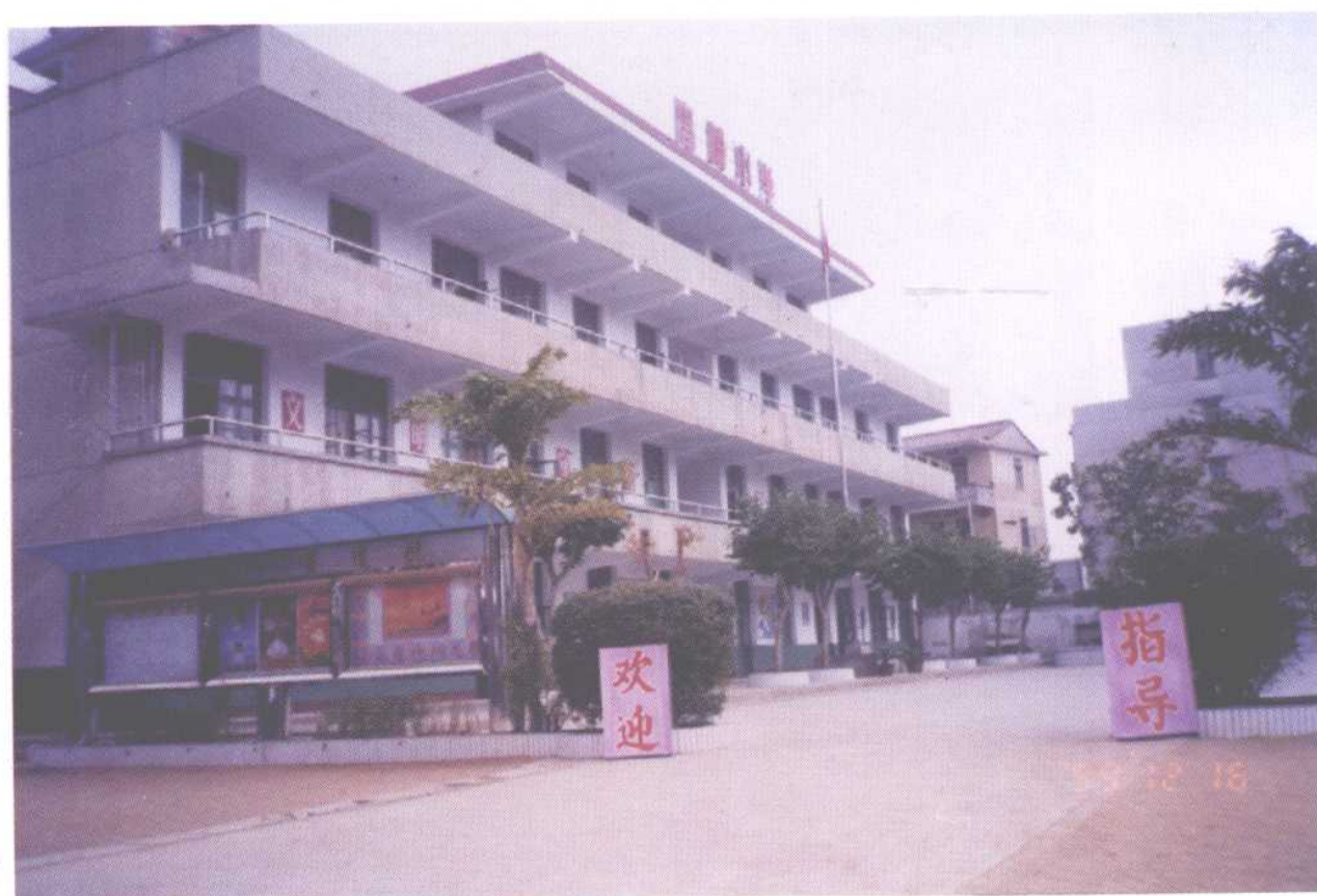
高崎小学教学综合楼
