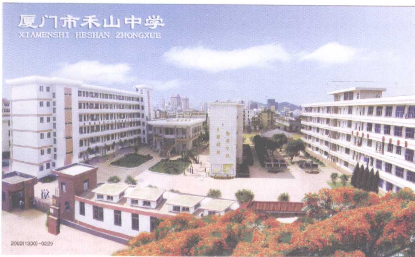
禾山中学校园全貌
