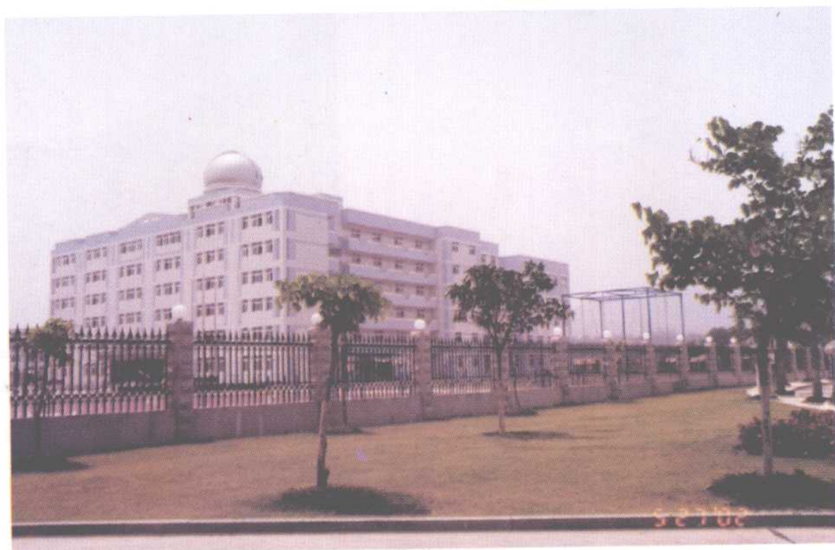
2001年新建的金尚中学教学综合楼
