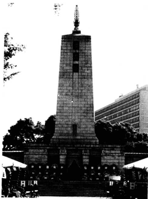
▲大阪市大手前大阪城公園内
