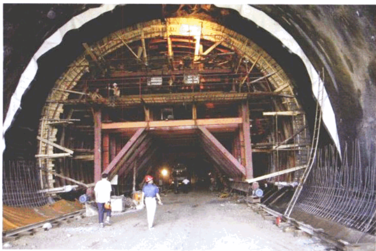
铁路-分水关隧道
