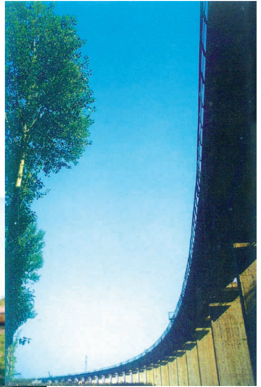
高架铁路立交桥
