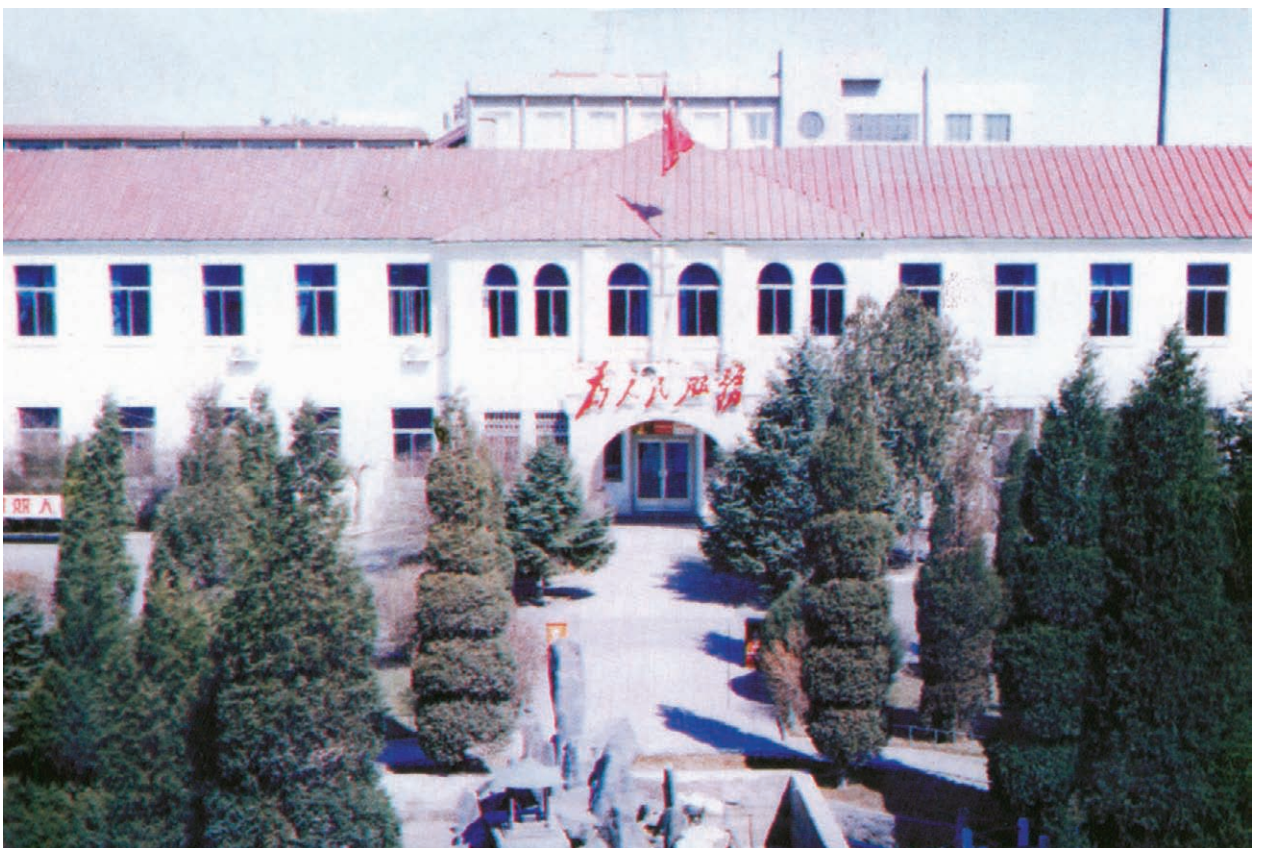
新民市人民政府机关办公楼
