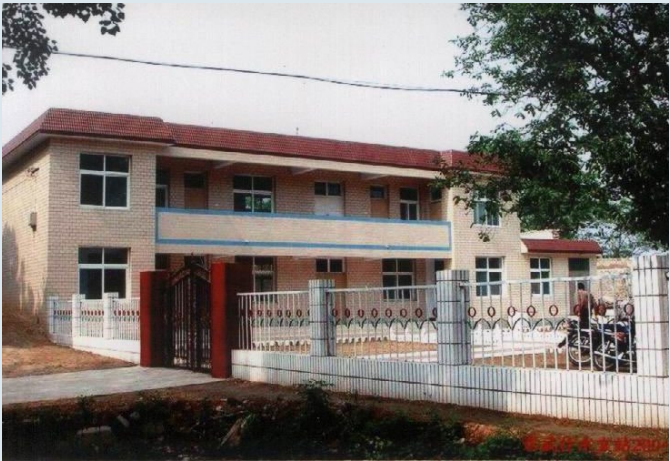
2002 年建东武仕水库水文站站房
