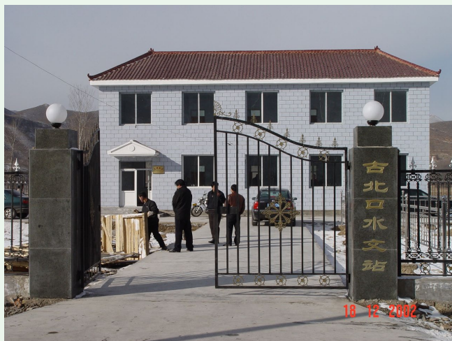
2002 年建古北口水文站站房
