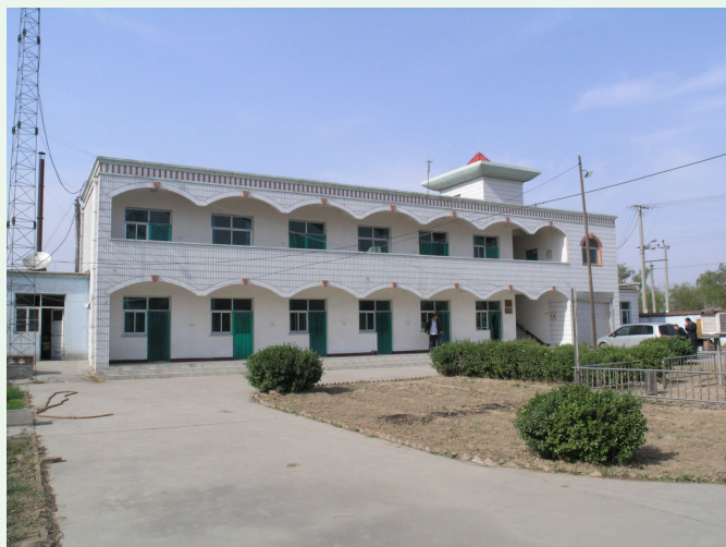
新盖房水文站站房
