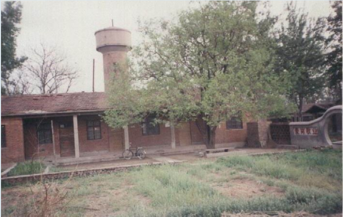
1985 年建东武仕水库水文站站房
