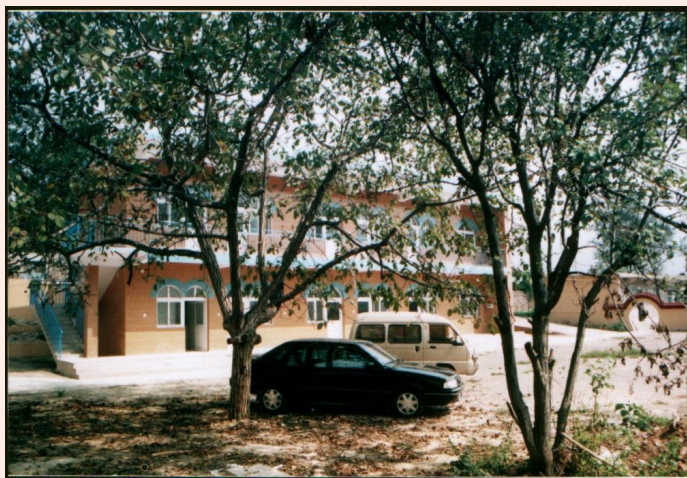
2002 年建朱庄水库水文站站房
