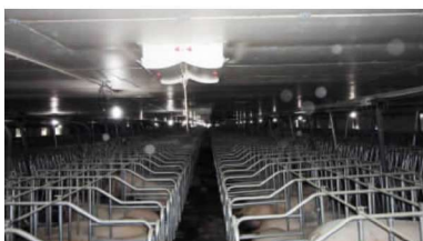
妊娠舍屋顶通风系统
