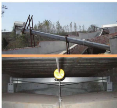
全自动控制粪板清粪系统
