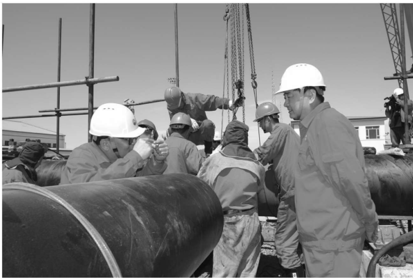
邹立军（右）针对实际分析制订管道改造动火施工作业方案
