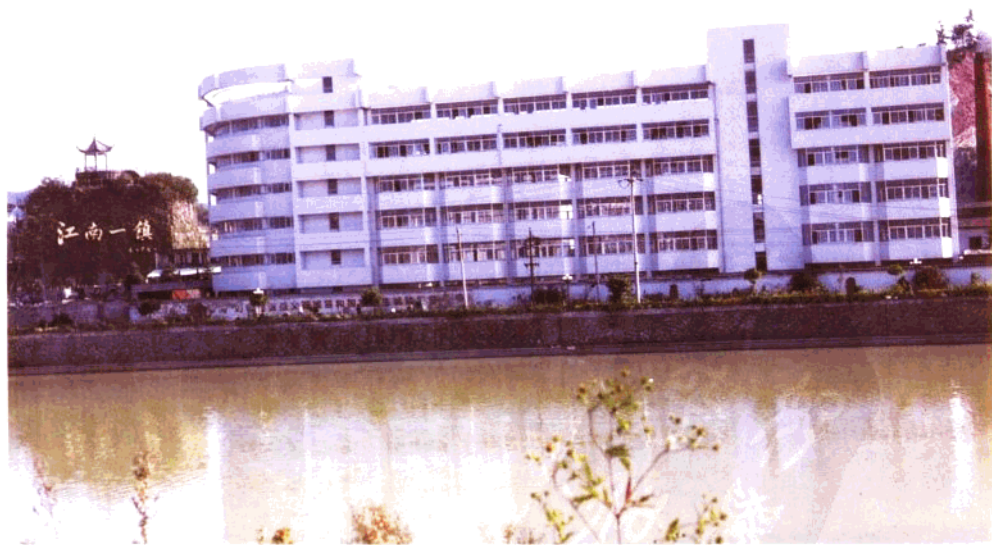
▲承建的东磁集团电机大楼，该工程获得浙江省建筑工程质量“钱江杯”奖
