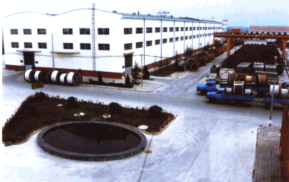
▲ 河北新华线缆集团公司工厂一角
