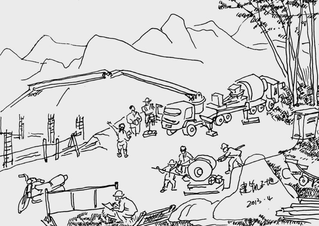
热闹的工地 2013年
