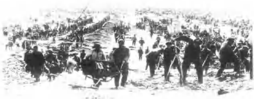
1951年冬到1952年春,百万人民开挖苏北灌溉总渠
