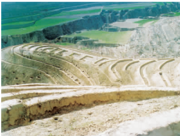
退耕还林工程“88542” 水平沟整地模式
