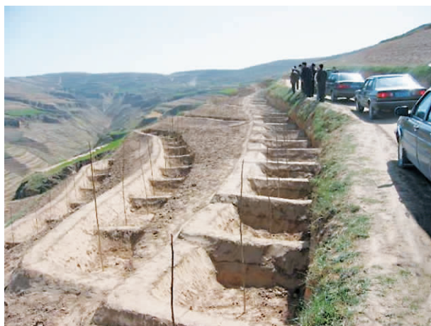
退耕还林工程“66431” 水平沟整地模式
