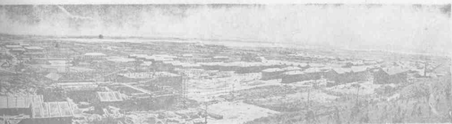
建設中的我院全景。
