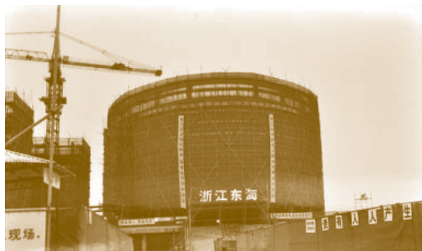
一期工程 - 综合楼
