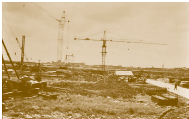
2000 年 5 月建造打桩现场
