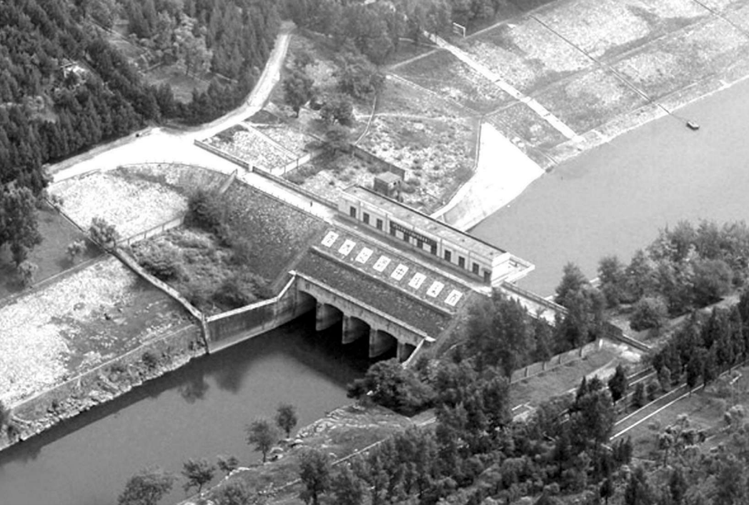
◎ 20 世纪 60 年代修建的老渠首部闸航拍图 ◎
