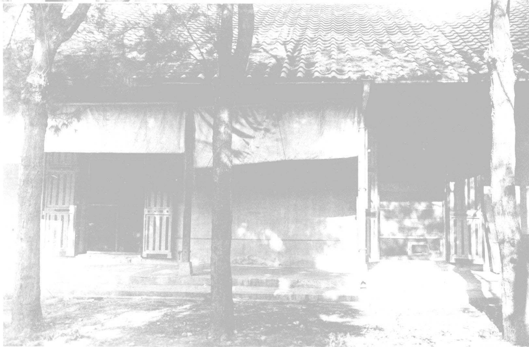
(上) 北部試験倉庫ノ一 (板橋倉庫)
