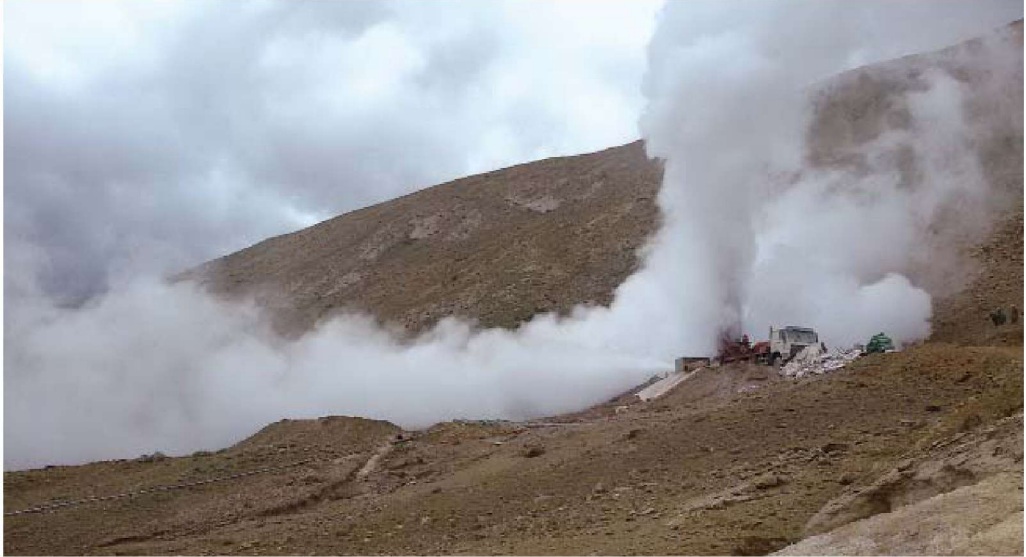
▲ 图1-2 地热蒸汽 (西藏蒸汽井施工现场)
