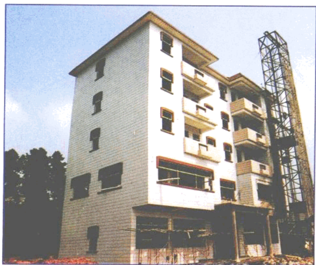
建设中的镇派出所办公大楼
