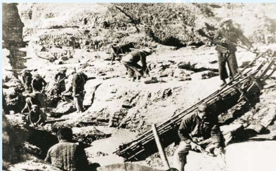
兴修水库工地
