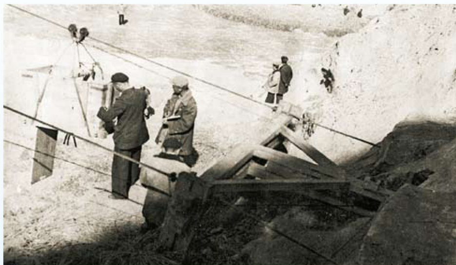
兴修水库工地
