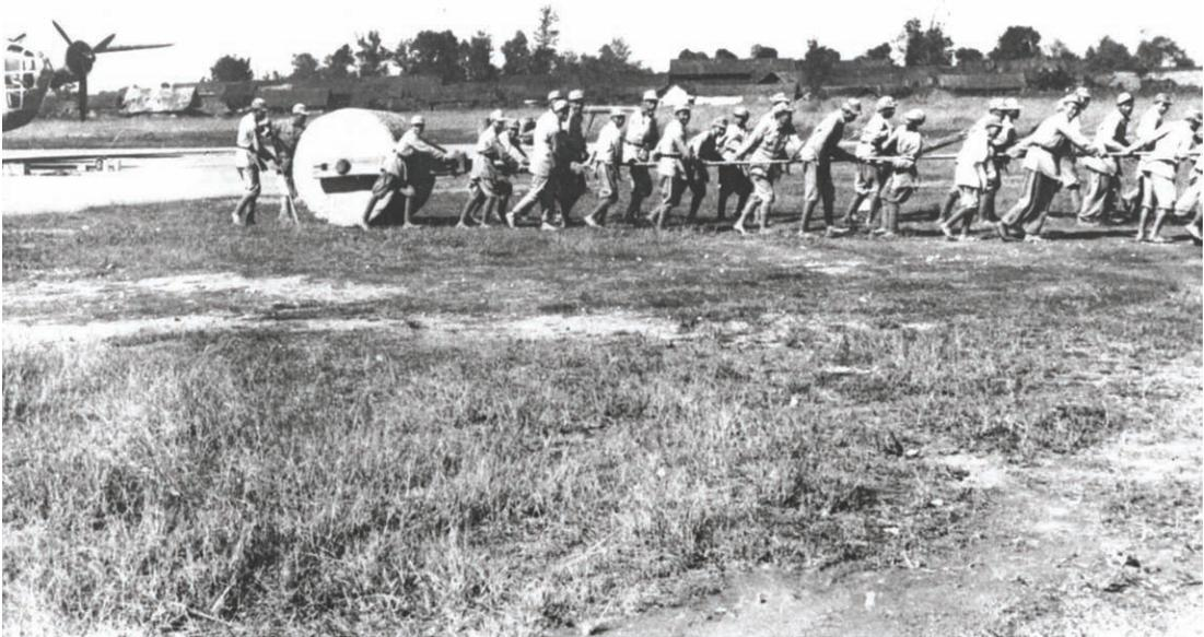
用最原始的施工方法建设军用机场
