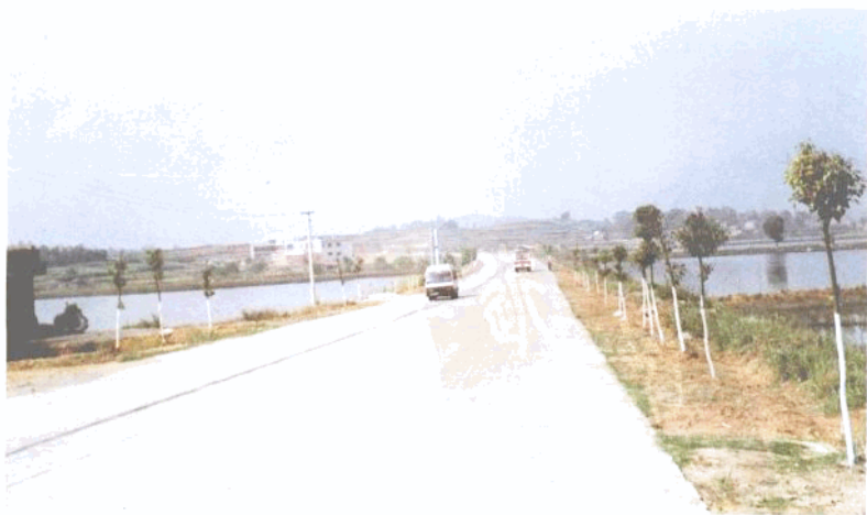
梁兴二级公路
