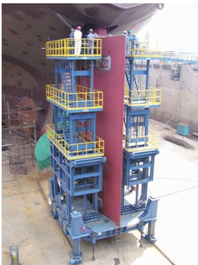
为广船国际股份有限公司提供的艏部作业平台在艏部桨叶安装中应用
