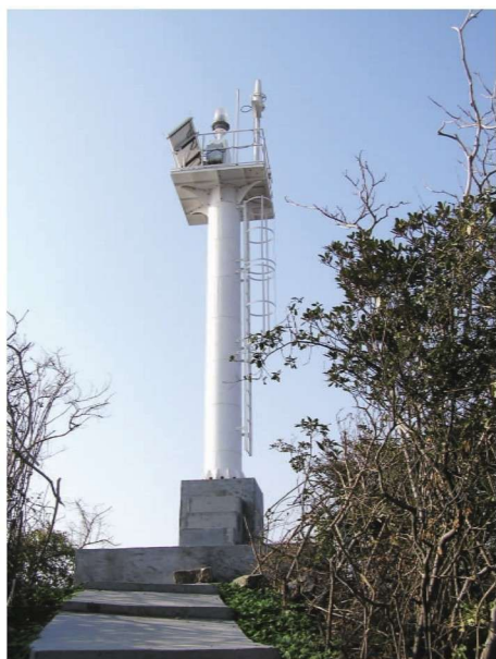
热喷涂应用于东海小戢山航标灯塔
