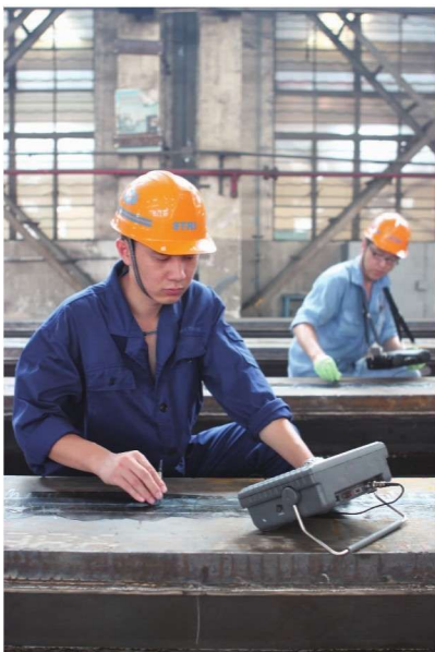
虹桥机场西航站楼钢结构超声波探伤由上海船舶工程质量检测有限公司承担
