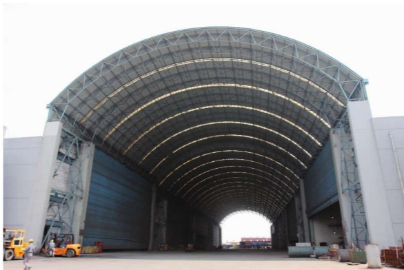
为江苏新时代造船有限公司提供的大型船体分段涂装房工程总承包
