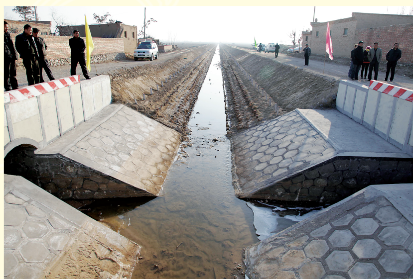
土地整理项目工程建设
