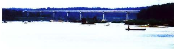
区境内 206 国道沙咀头大桥
