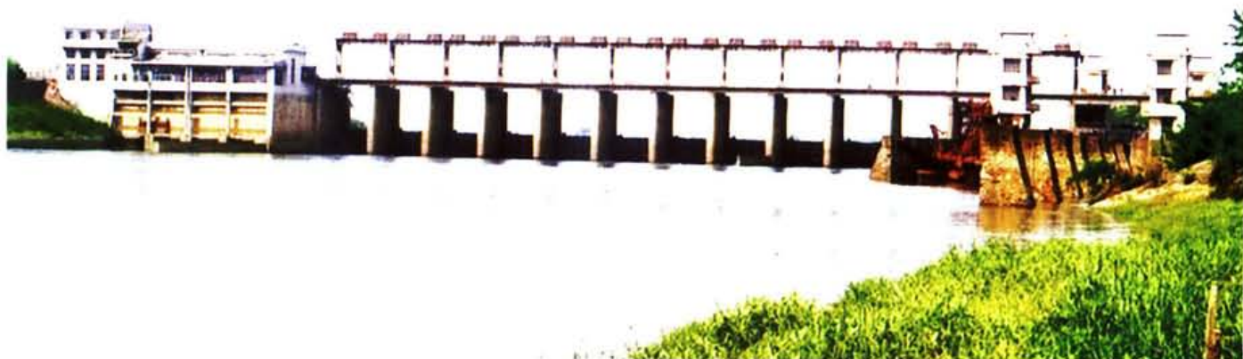
国家重点建设工程——鱼山渠化工程
