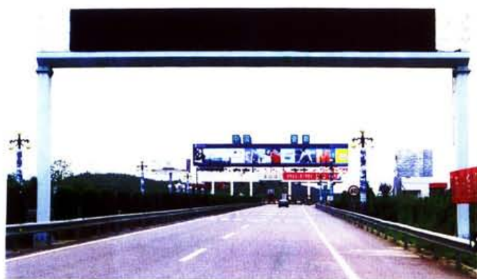
区境内九景高速公路
