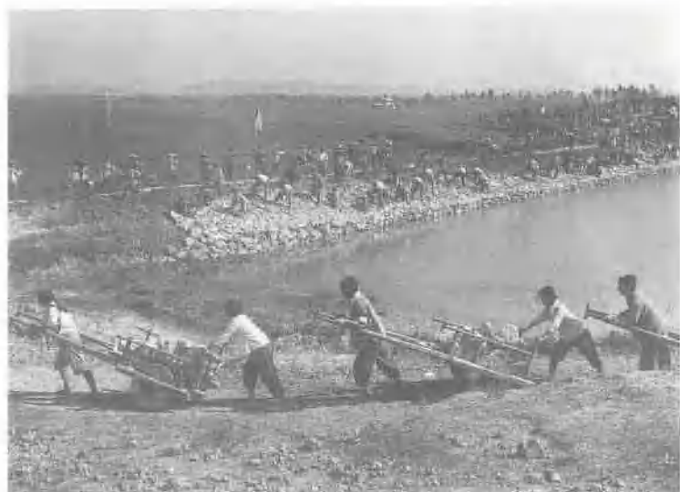
P58 文 清平水库建于 1958 年冬，图为兴建中的一个施工场面。
